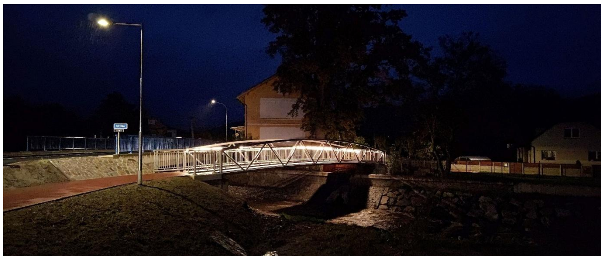
Obr. 13: Lávka přes řeku Desná
