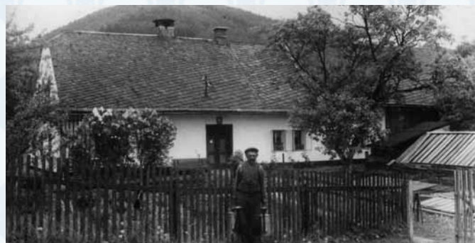
Zahradnictví a květinářství Leopolda Schindlera čp. 144 s jeho majitelem – snímek z roku 1937.
