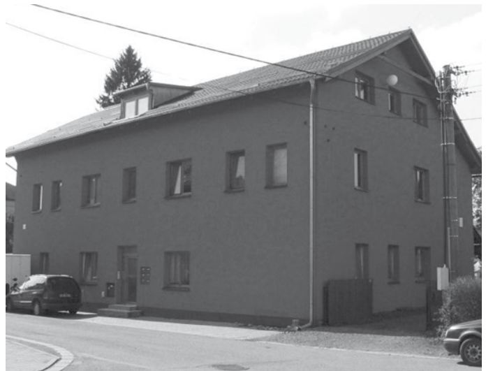
Rekonstrukce bytového domu, Družstevní ulice, Rapotín, 2013
