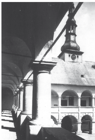
Vnitřní nádvoří zdobí otevřené jednopatrové arkády s toskánskými sloupy z maletínského pískovce a s ochozy zaklenutou křížovou klenbou.
