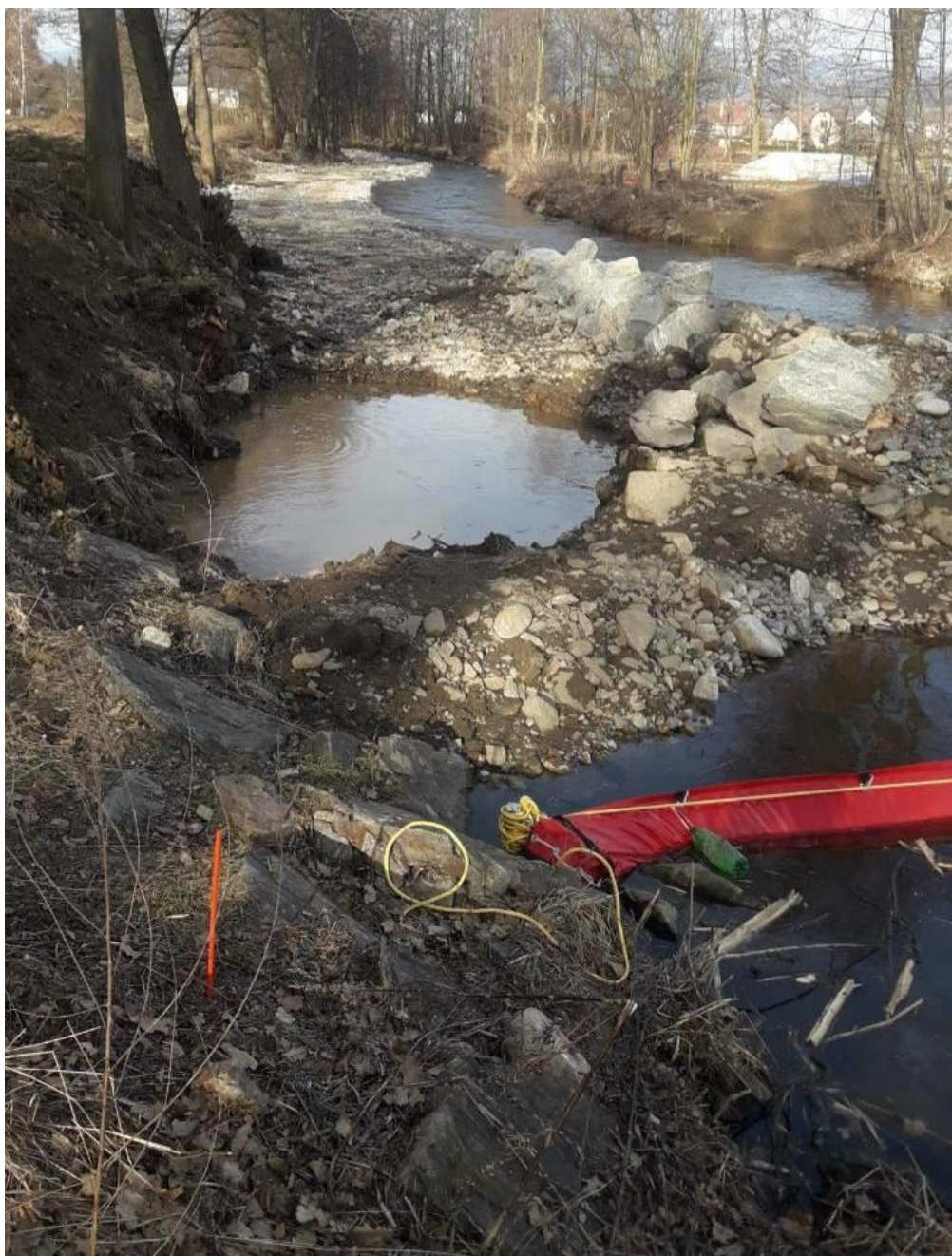
Obrázek 7: budování pojezdové hrázky v toku Desné, přípravné práce na prohrábkou koryta
