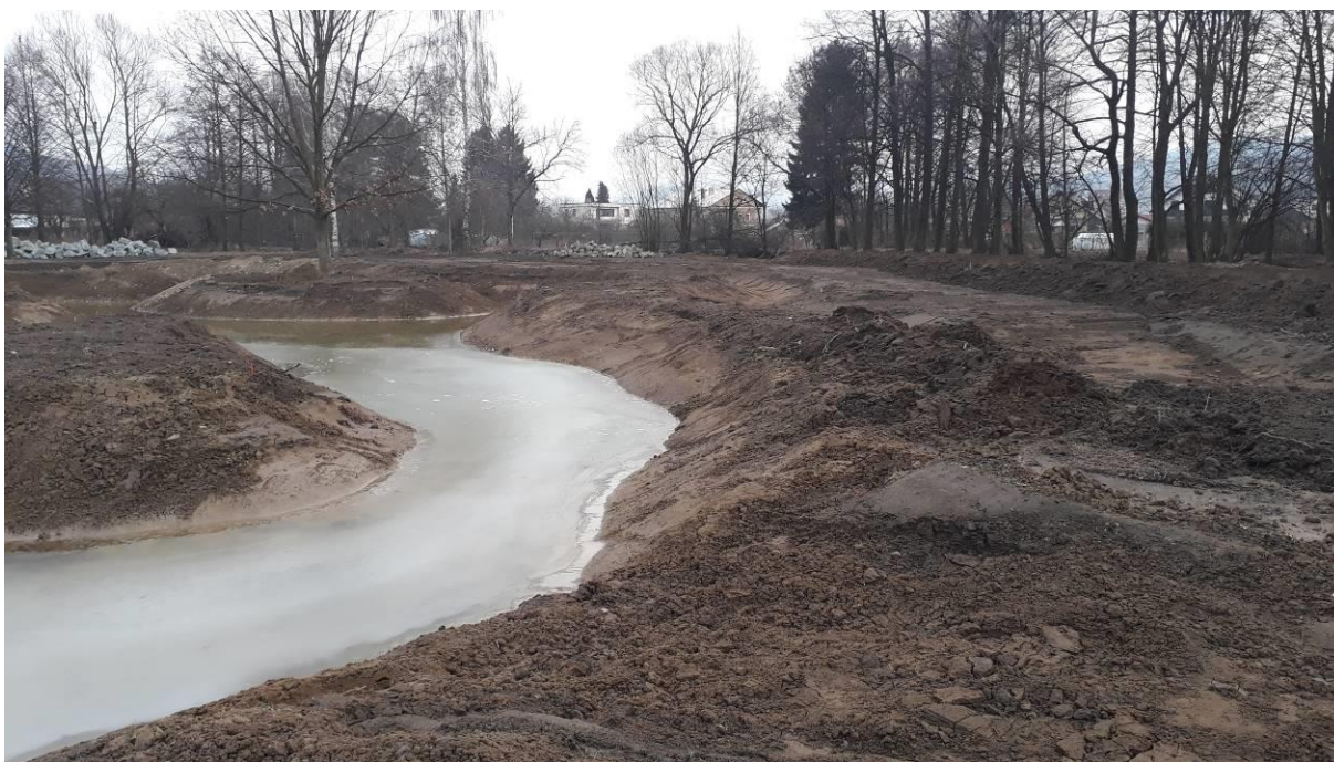
Obrázek 6: zemní práce na povodňovém parku č.1
