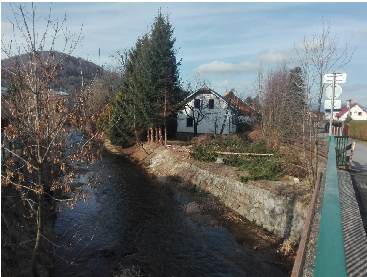
Obrázek 3: kácení stromů v prostoru celého staveniště
