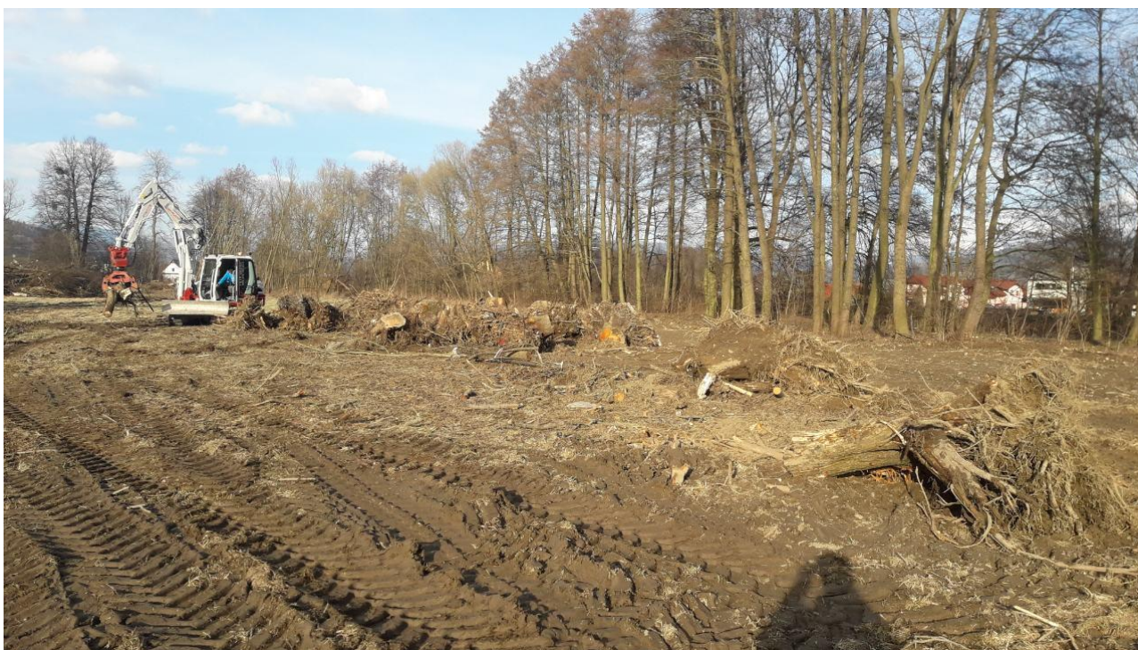
Obrázek 4: kácení stromů a likvidace pařezů na povodňovém parku č. 3
