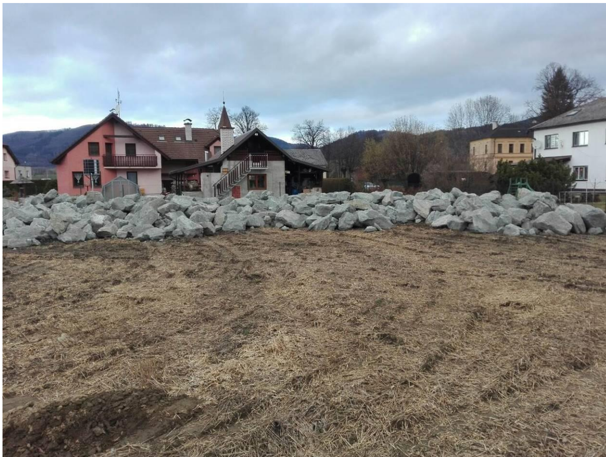
Obrázek 5: návoz lomového kamene pro zpevnění břehů
