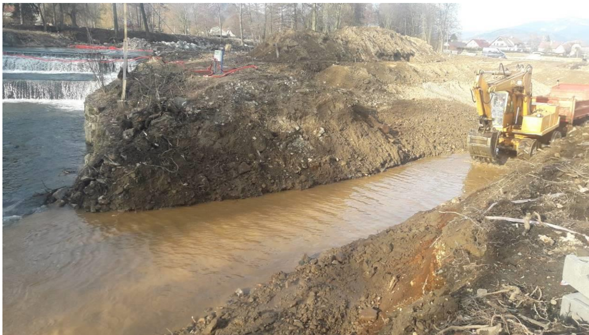
Obrázek 1: Povodňový park č.2 – zemní práce na rybím přechodu
