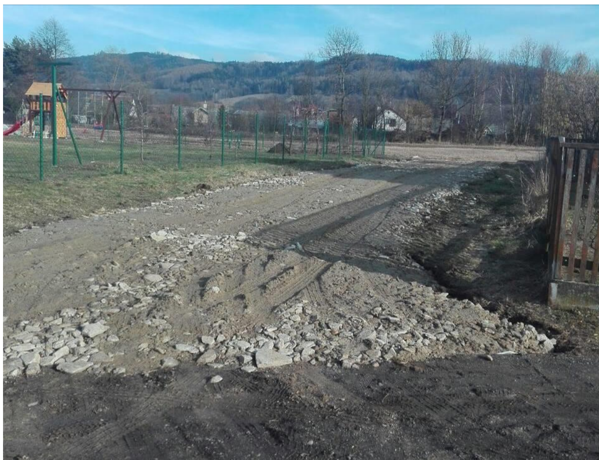
Obrázek 2: budování příjezdových komunikací pro jednotlivé staveniště
