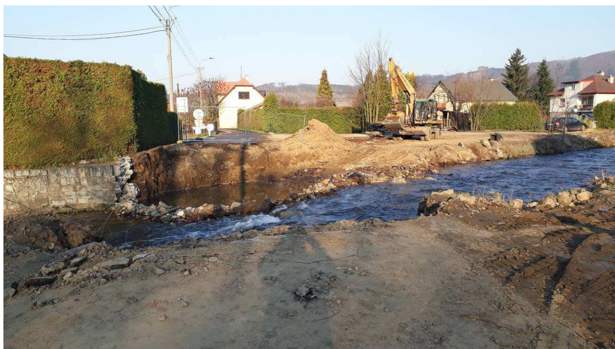
Obrázek 2: dokončovací práce na demolici mostu SO11
