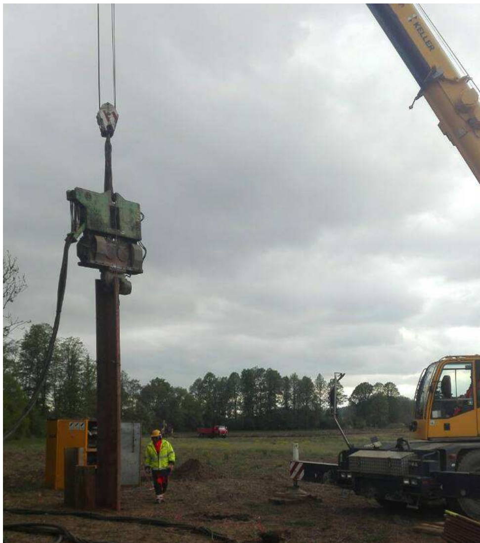
Obrázek 9: beranění štětovnic na povodňovém parku č.3 – SO 15.1.1
