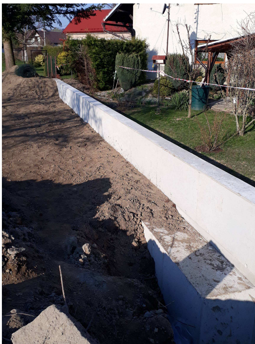
Obrázek 4: monolitická ZB zídka na objektu SO03
