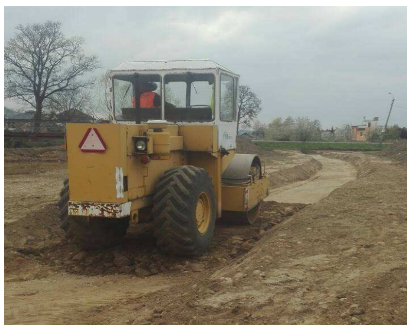
Obrázek 10: zemní práce na povodňovém parku č.5
