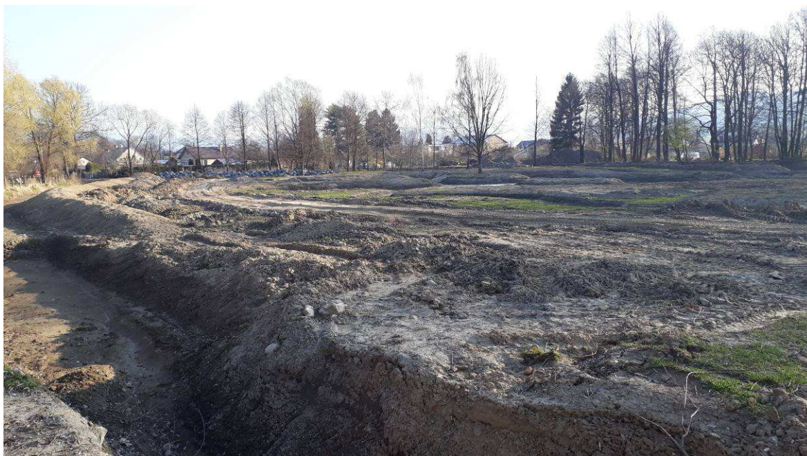
Obrázek 3: pokračování zemních prací na povodňovém parku č.1 a okolních objektech
