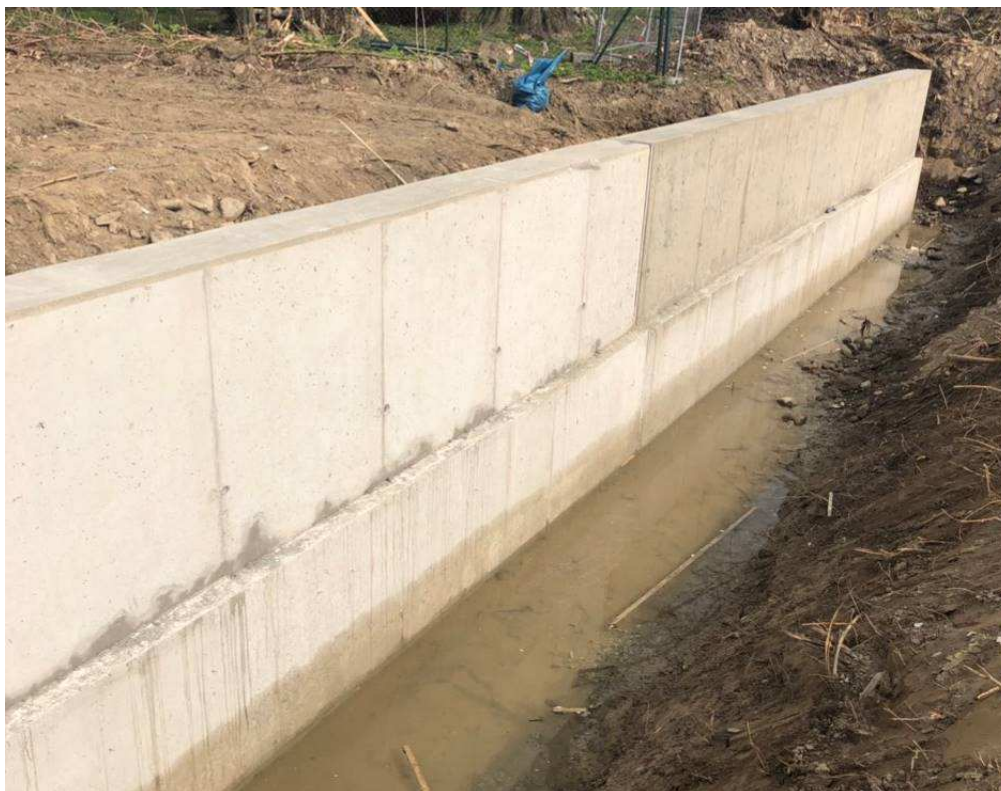
Obrázek 7: hotová monolitická ŽB zídka na objektu SO 14.2
