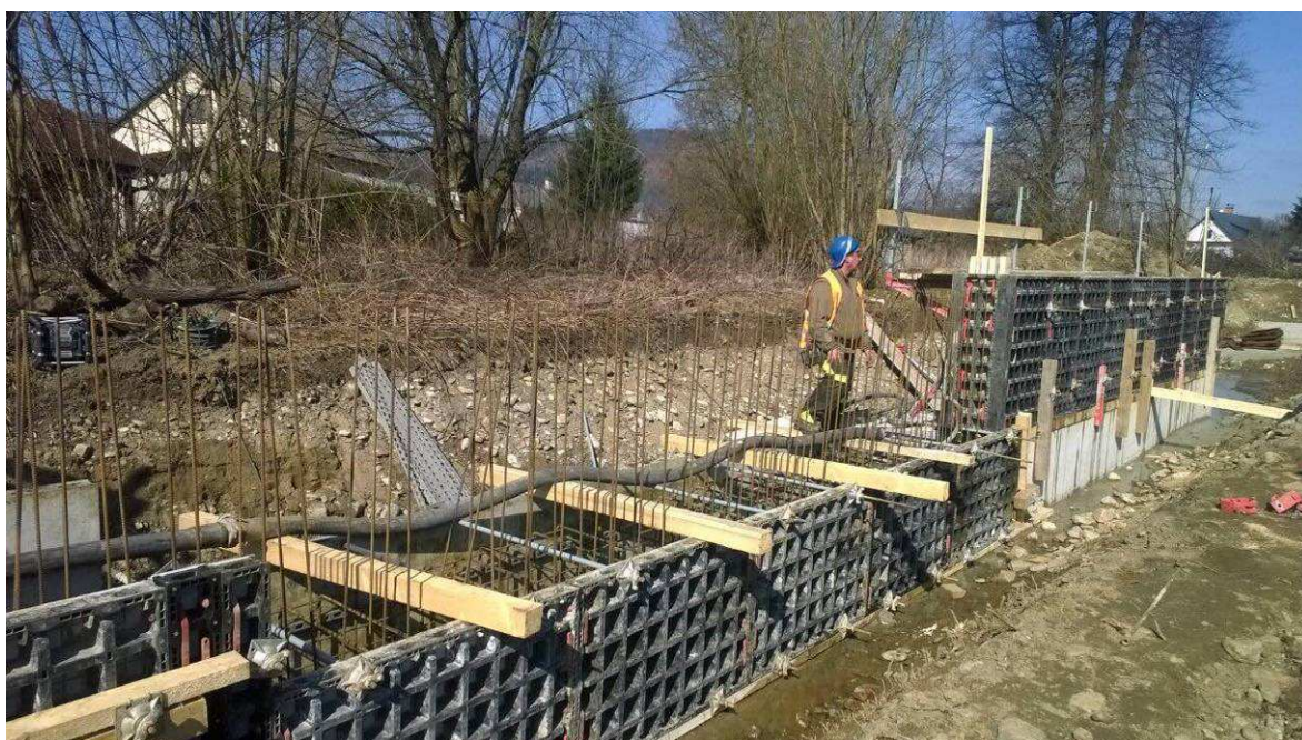
Obrázek 6: bednění, vázání výztuže a betonáž stěn na SO14.2 v povodňovém parku č.3
