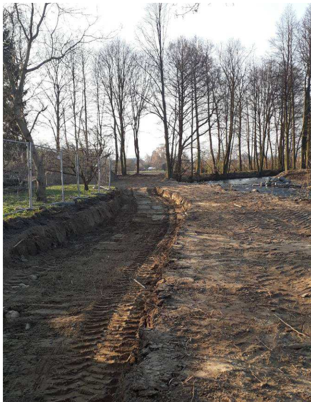
Obrázek 1: zemní práce na objektu SO09
