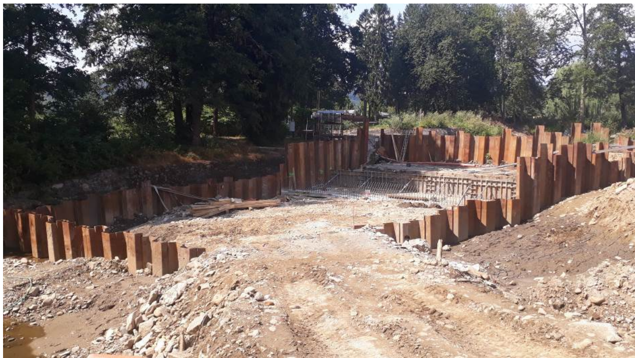
Obrázek 1: štětovnicová jímka jezu – provedeny bourací, zemní práce a tryskové injektáže. Příprava na monolitické konstrukce
