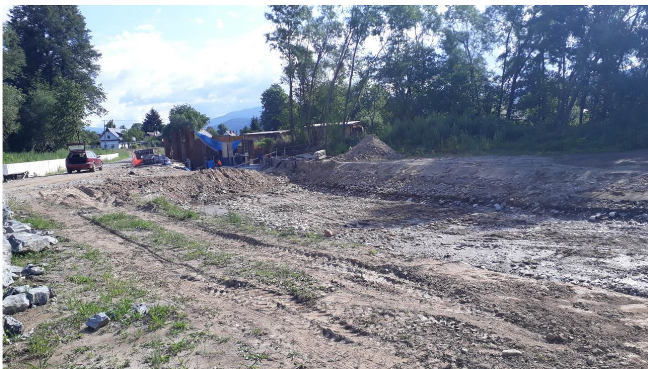
Obrázek 4: Zemní práce na povodňové parku č.3 (v pozadí práce na objektu SO15.1.1)
