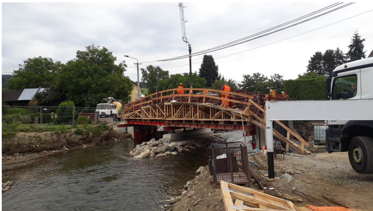
Obrázek 7: betonáž mostovky mostu SO11
