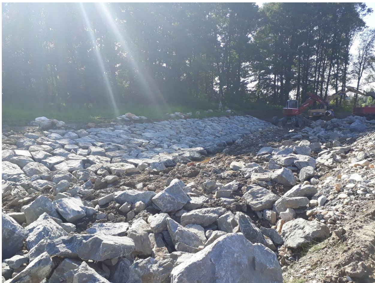
Obrázek 11: provádění kamenných záhozů na povodňové parku č. 3 (SO15)
