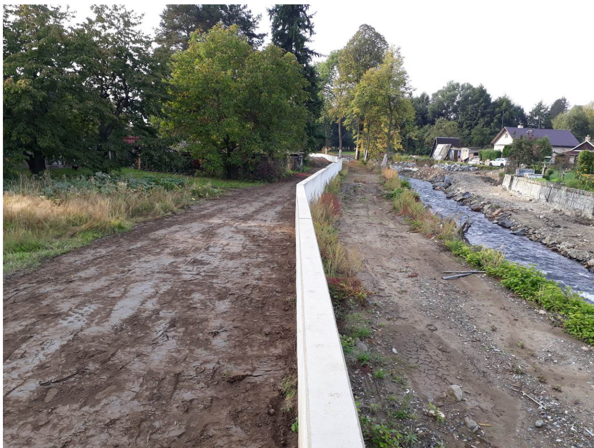
Obrázek 8: zpětné zásypy na betonové zídce SO09
