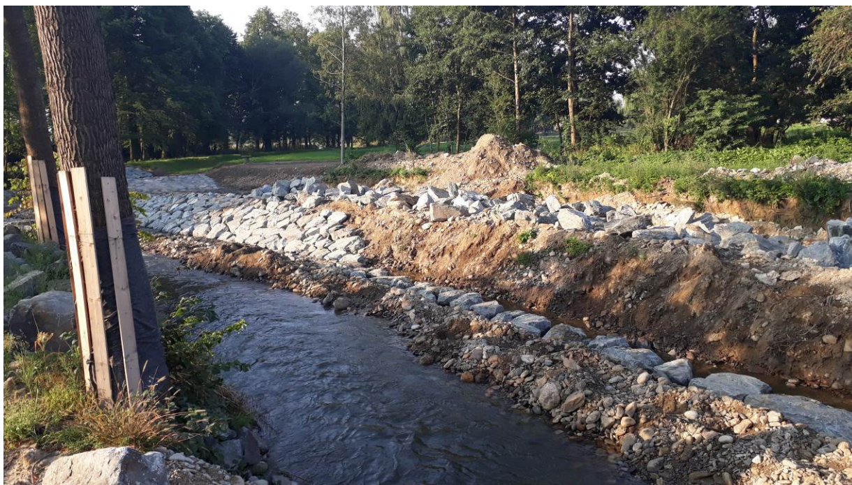
Obrázek 7: kamenné záhozy na SO06 (pohled směrem k parku č.1)
