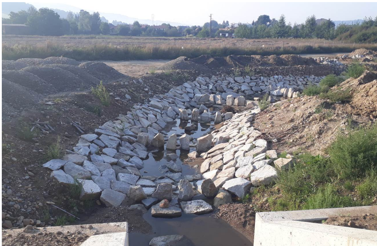
Obrázek 4: stavba rybího přechodu SO10.1
