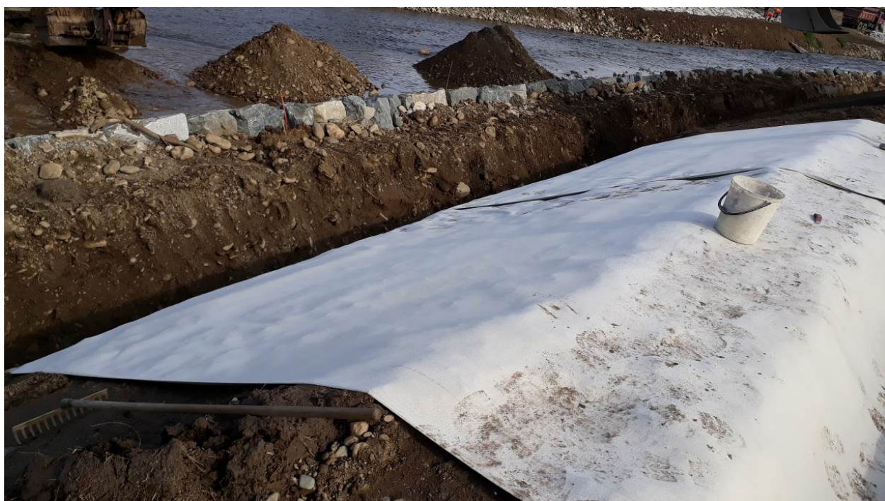
Obrázek 12: pokládka bentonitových rohoží na parku č.5 – SO 43 a SO44
