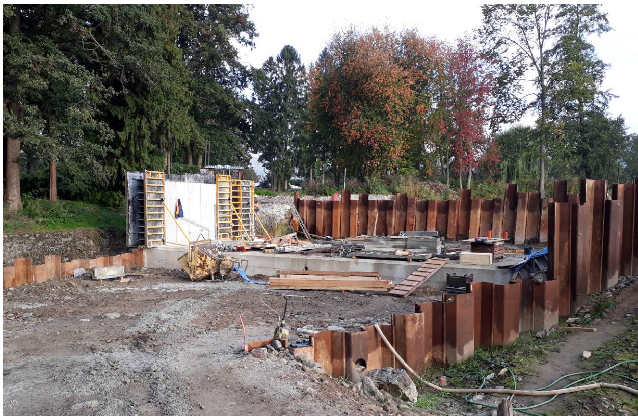
Obrázek 1: bednění a betonáž pravobřežní zavazovací zdi na jezu Červený dvůr
