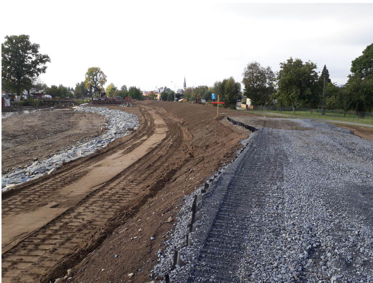
Obrázek 13: KTÚ na parku č.5 (SO44) – ohumusování, osetí, pokládka geobuněk včetně šterkování
