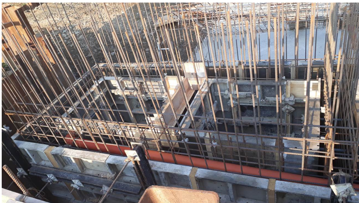
Obrázek 2: bednění a armatura armaturní šachty jezu Červený dvůr
