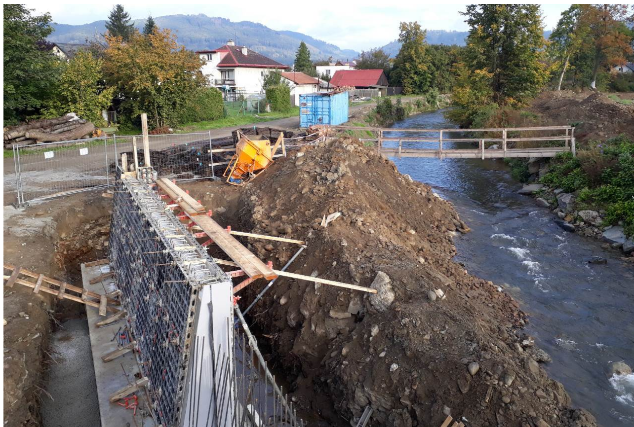
Obrázek 9: betonáž zídky na SO13 (pohled z mostu SO11)
