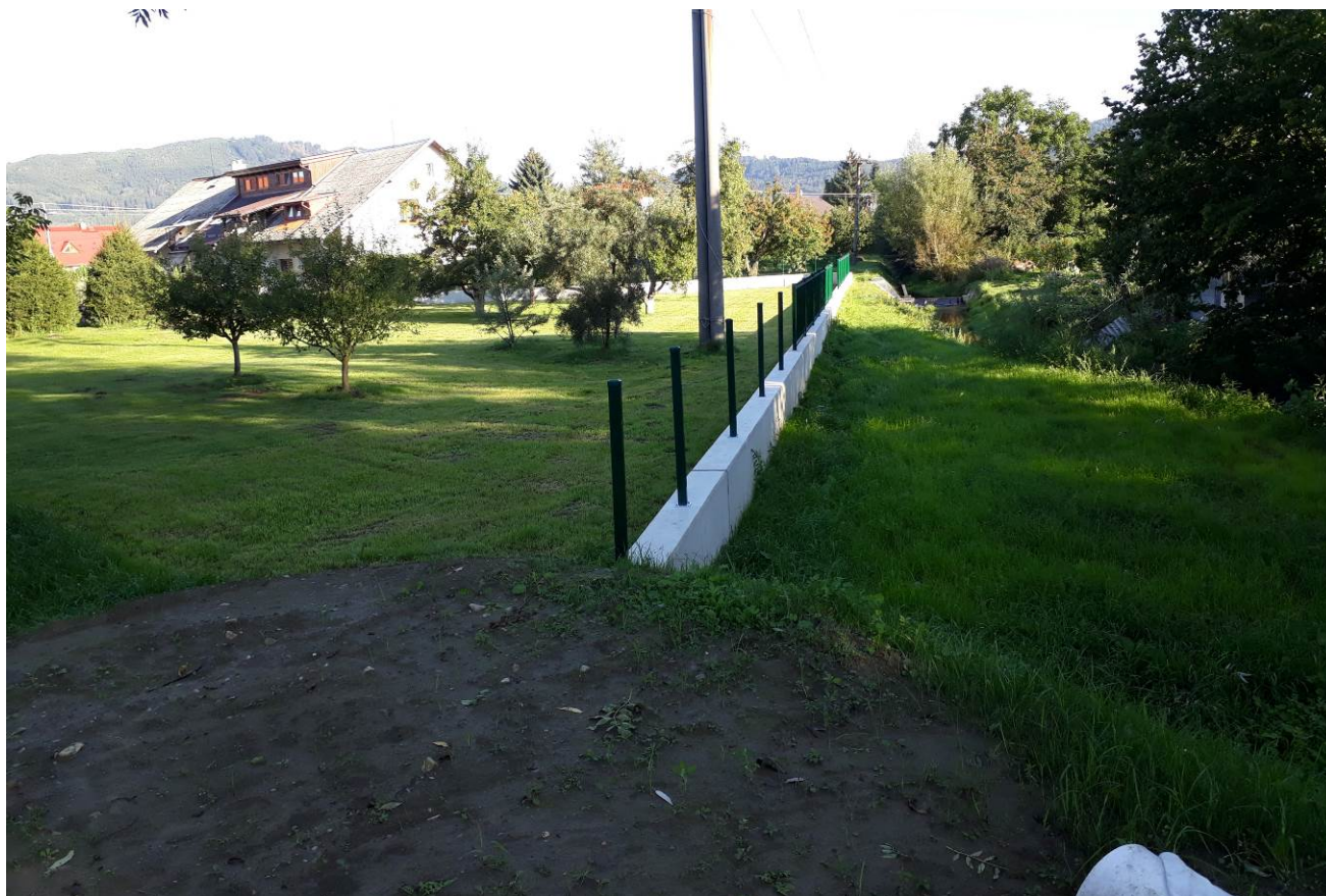
Obrázek 6: montáž oplocení na betonové zídce SO03
