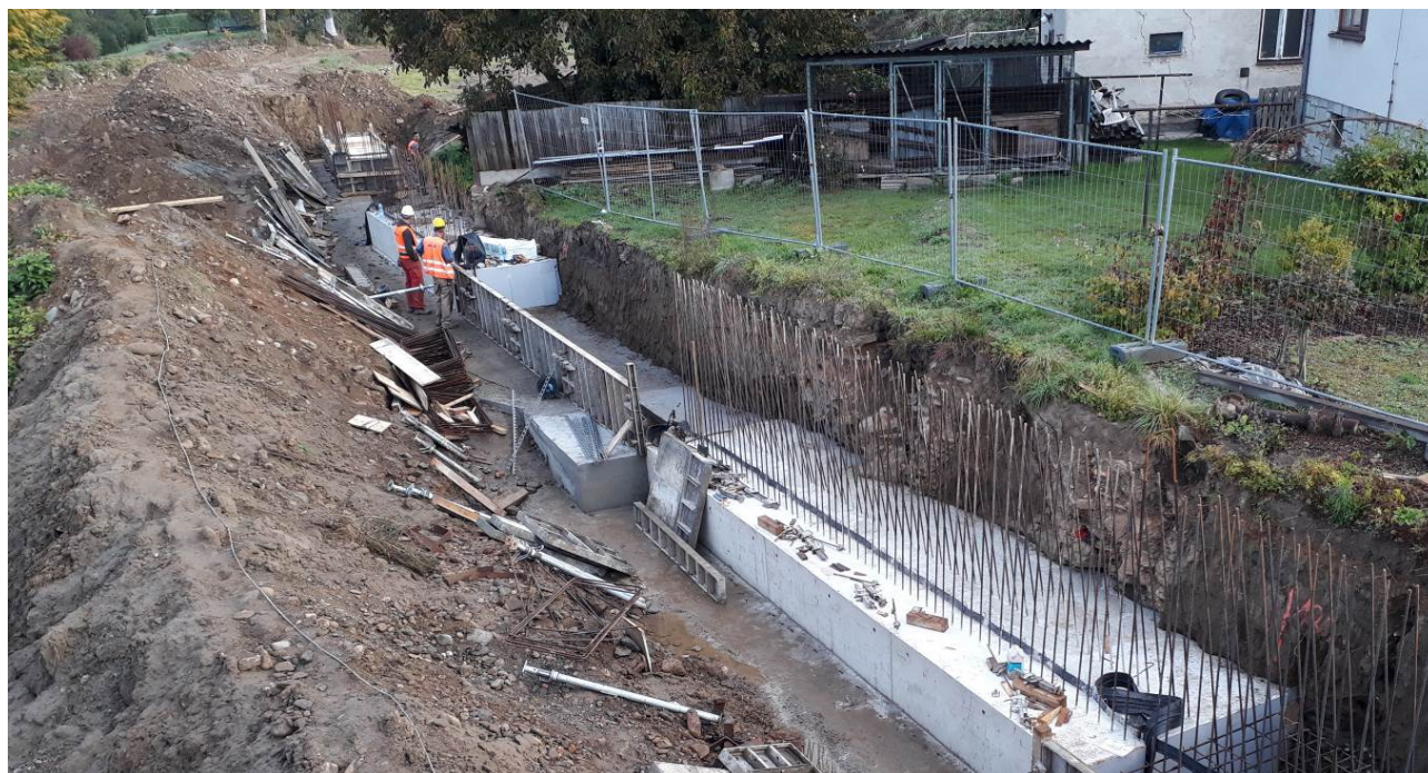
Obrázek 10: betonáž základu zídky SO22 (pohled z mostu SO11)
