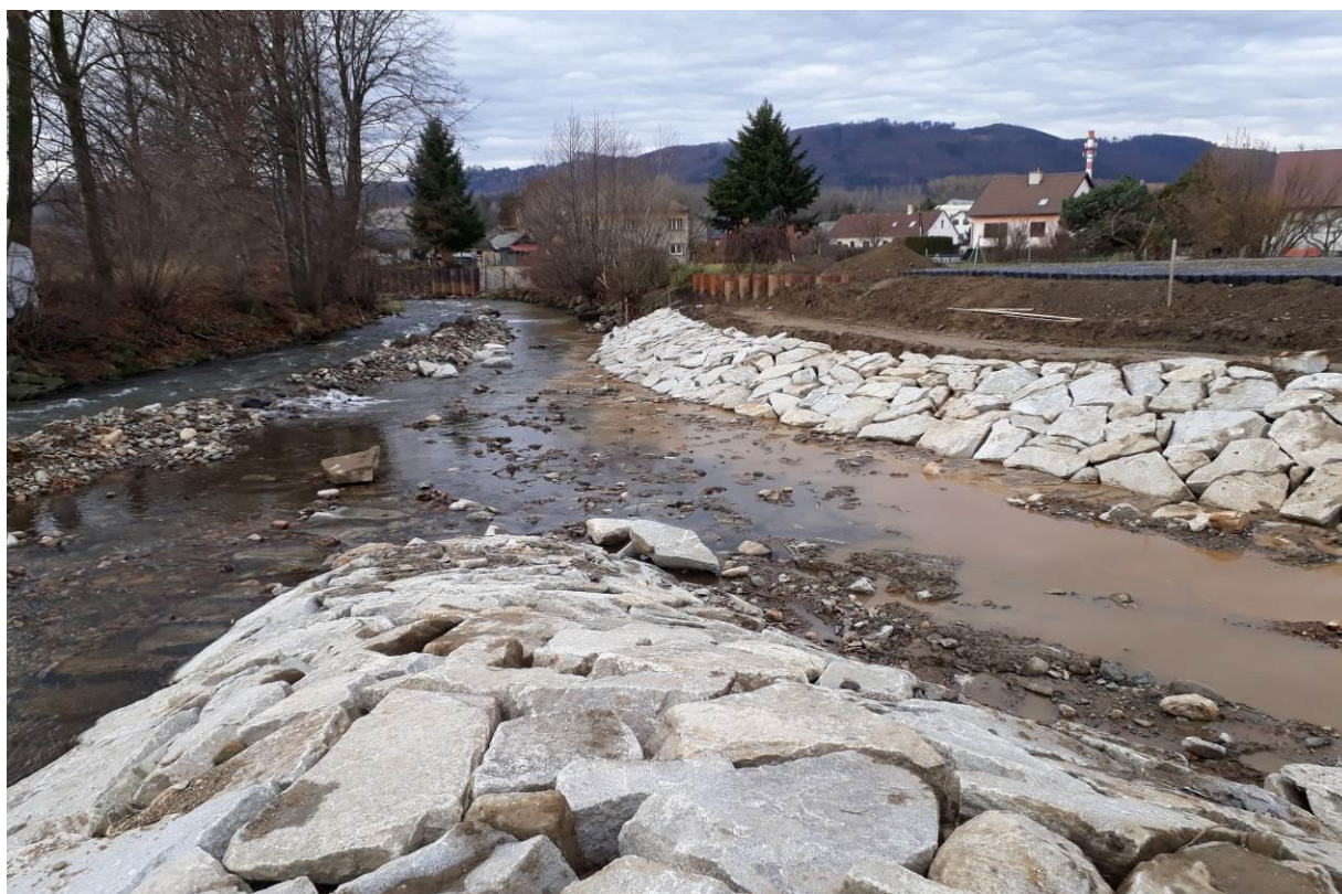
Obrázek 4: provádění kamenných záhozů na SO18
