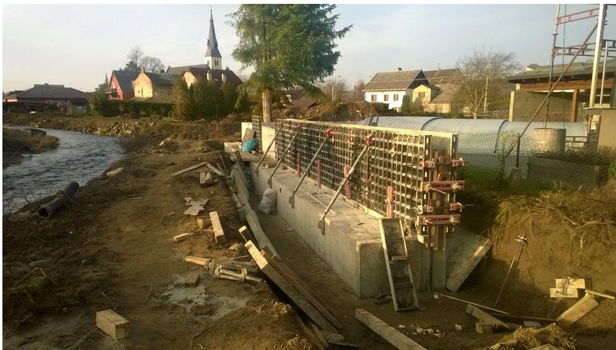
Obrázek 8: bednění a betonáž zídky SO41.1
