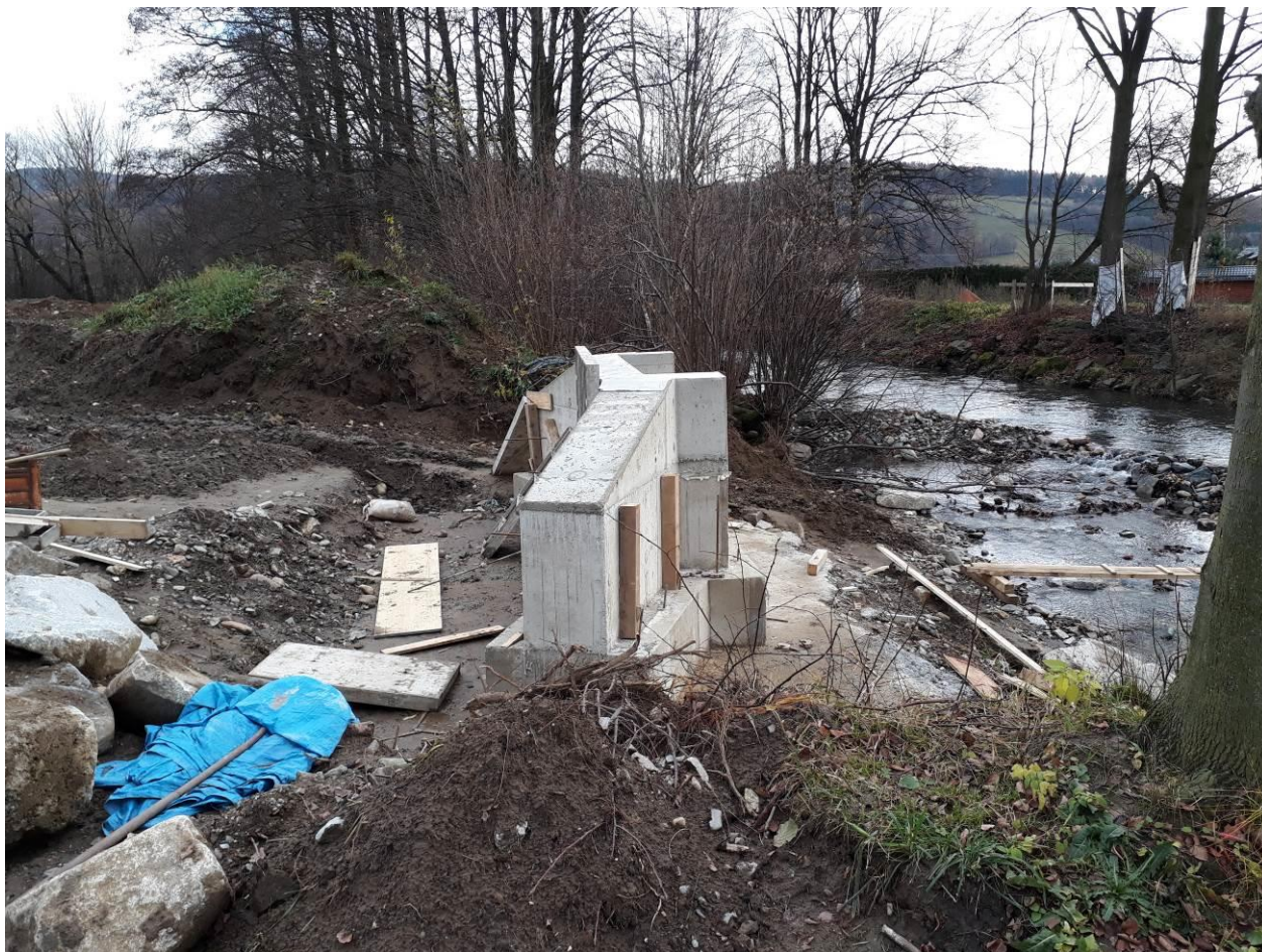
Obrázek 5: základy pro budoucí lávku na SO18.3
