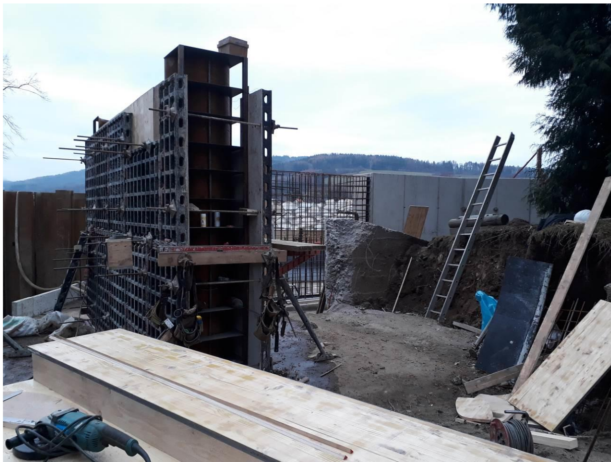
Obrázek 3: monolitické konstrukce na vtoku do elektrárny SO 01.2
