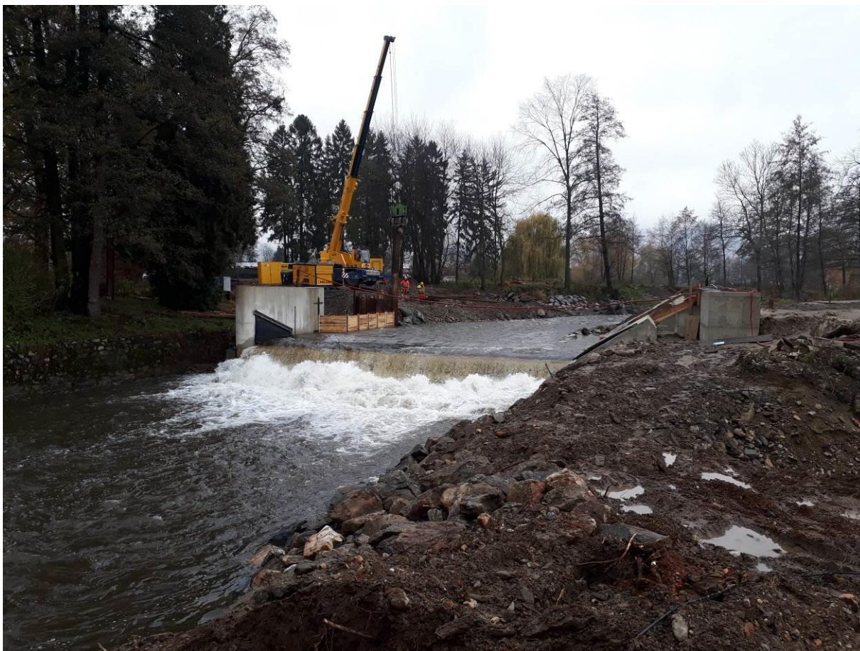
Obrázek 1: beranění štětovic na vtoku do náhonu
