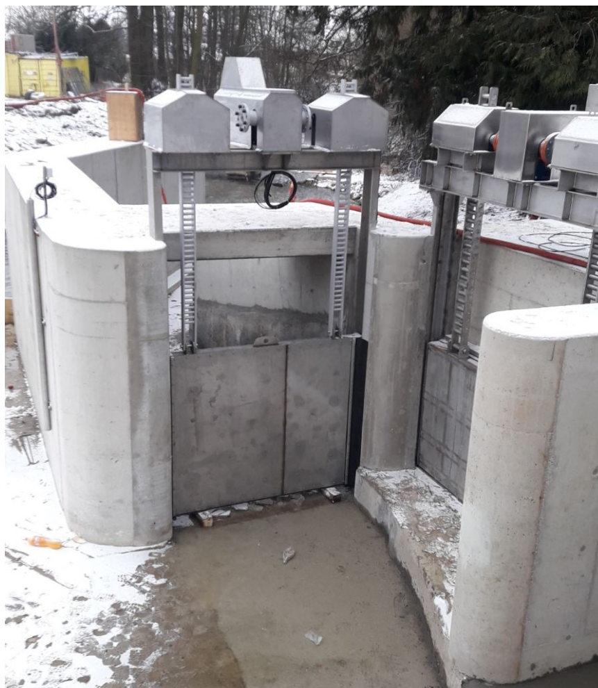
Obrázek 2: stavidla na vtoku do MVE, stavidlo štěrkové propusti SO 01.2
