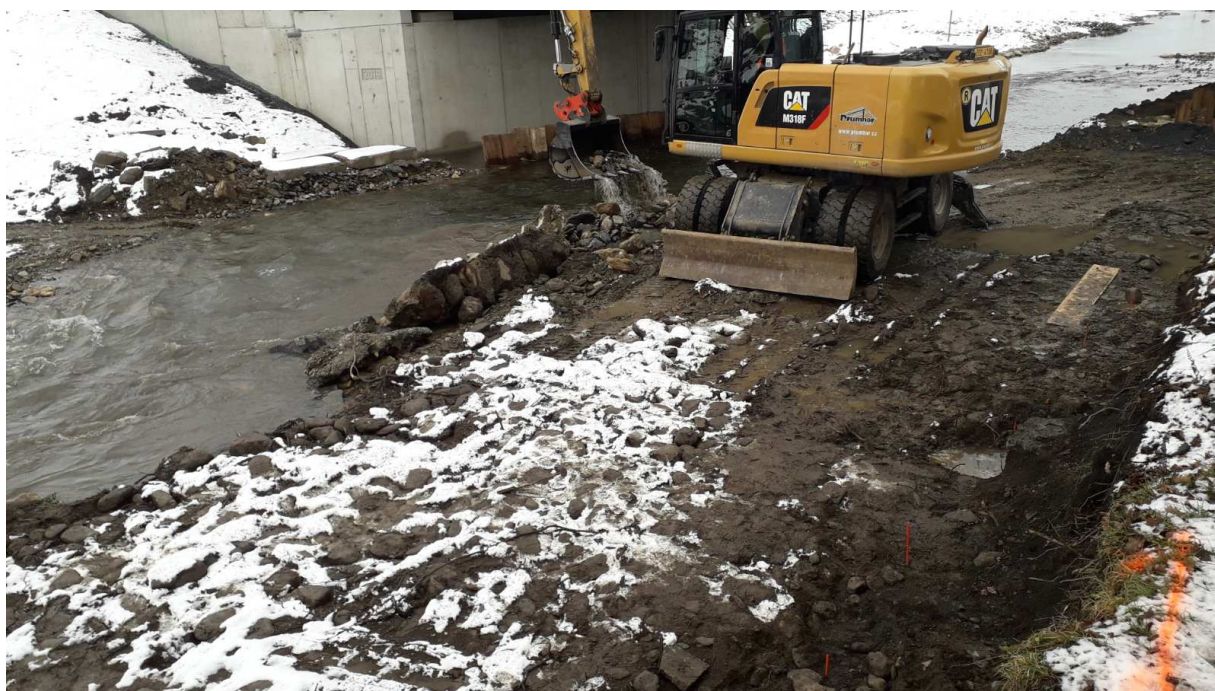
Obrázek 5: příprava pro provádění těsnící clony na SO 38.3
