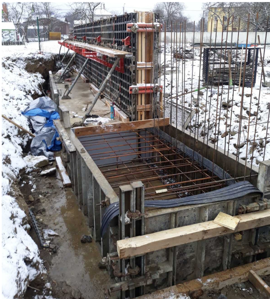
Obrázek 3: Betonáž zídky SO06.1
