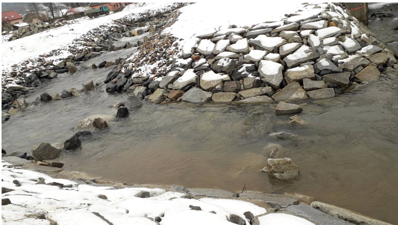
Obrázek 4: rybí přechod SO21
