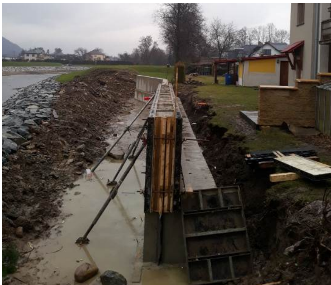
Obrázek 10: Bednění monolitické zídky SO43
