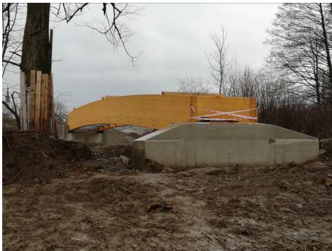
Obrázek 8: Usazená lávka SO 18.3
