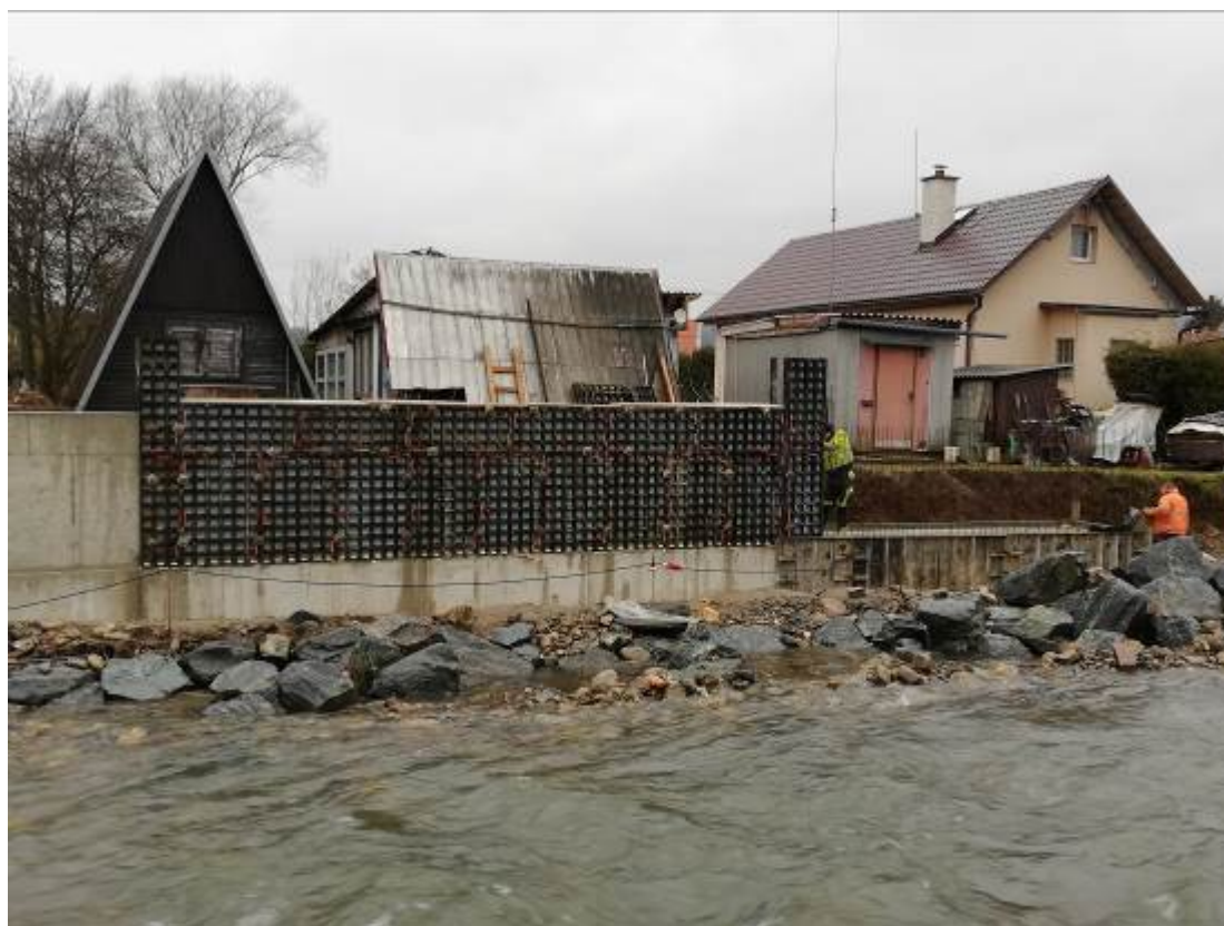
Obrázek 4: Bednění monolitické zídky SO06.1
