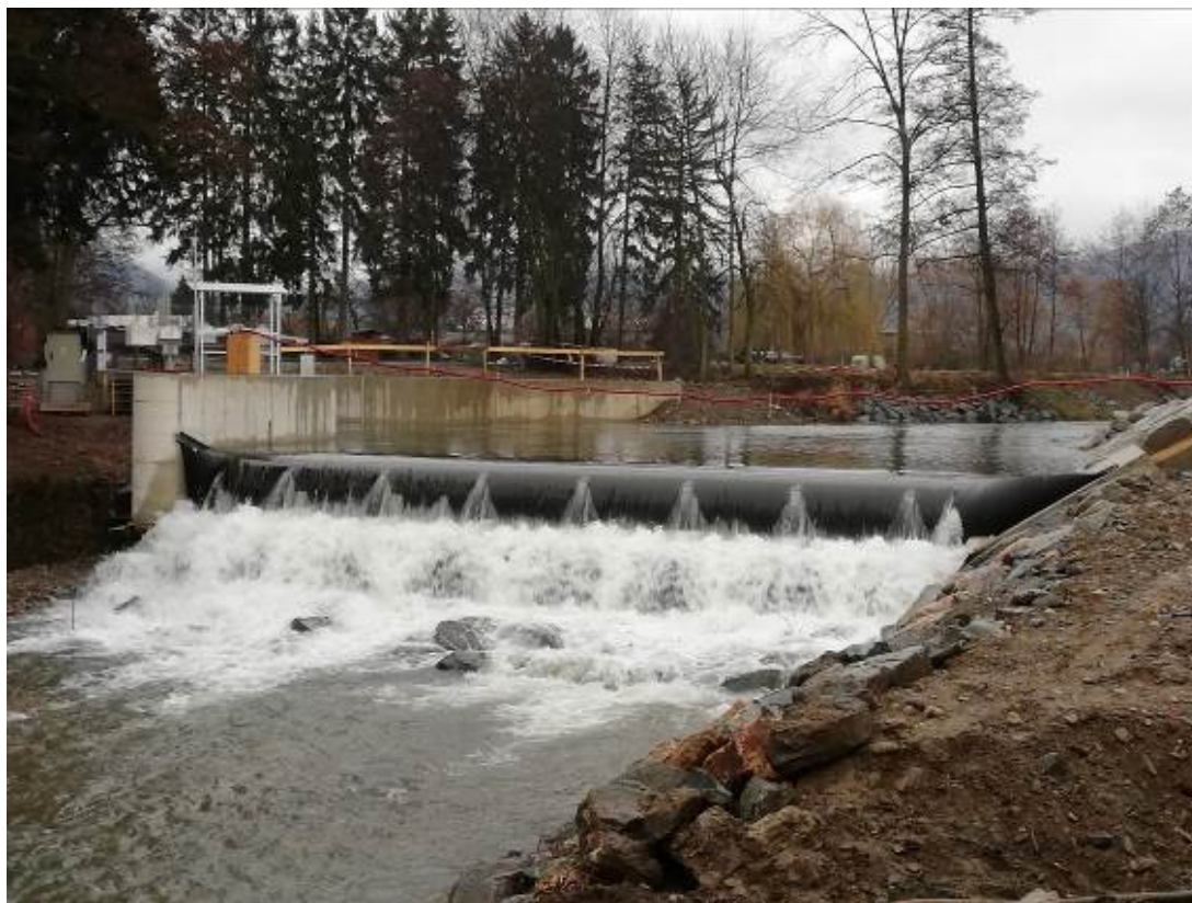
Obrázek 1: Zprovozněný vakový jez SO01.1a
