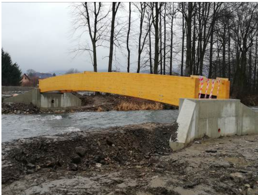
Obrázek 7: Usazená lávka SO15.3
