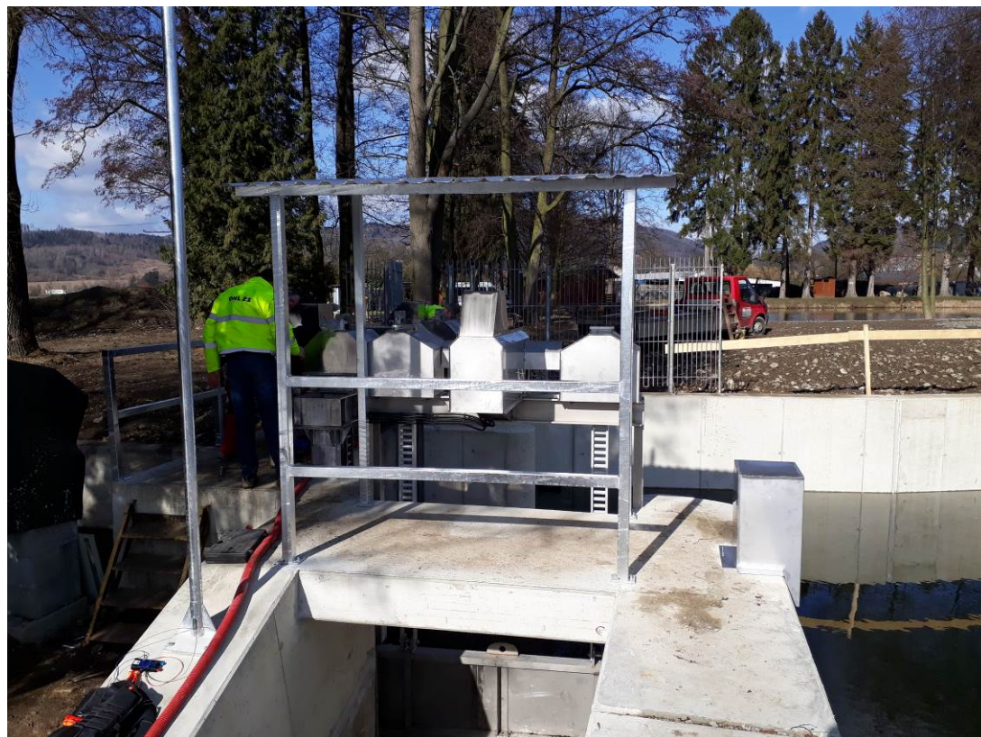
Obrázek 2: Zámečnické práce na SO01.2
