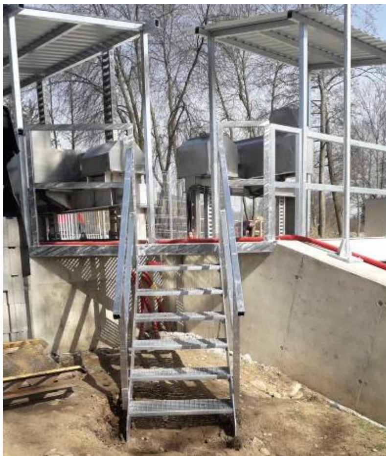
Obrázek 2: SO01.2 -montáž zámečnických konstrukcí
