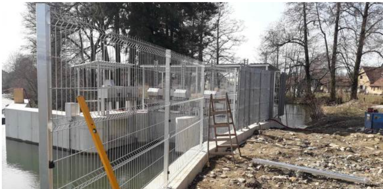
Obrázek 1: SO01.2 montáž oplocení
