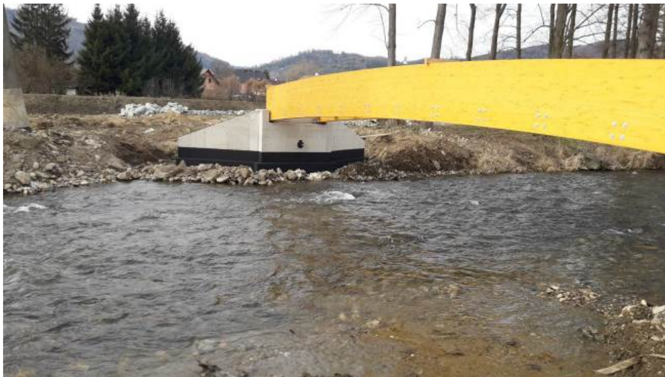
Obrázek 3: SO15.3 -izolační nátěr
