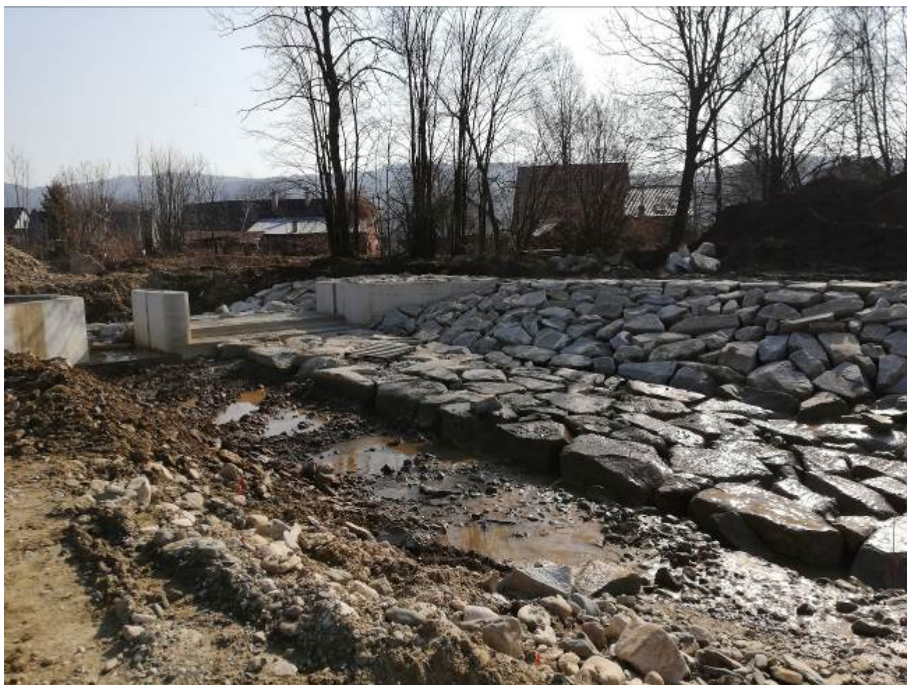
Obrázek 4: SO19 - dokončovací práce na vstupu do obtokového ramene
