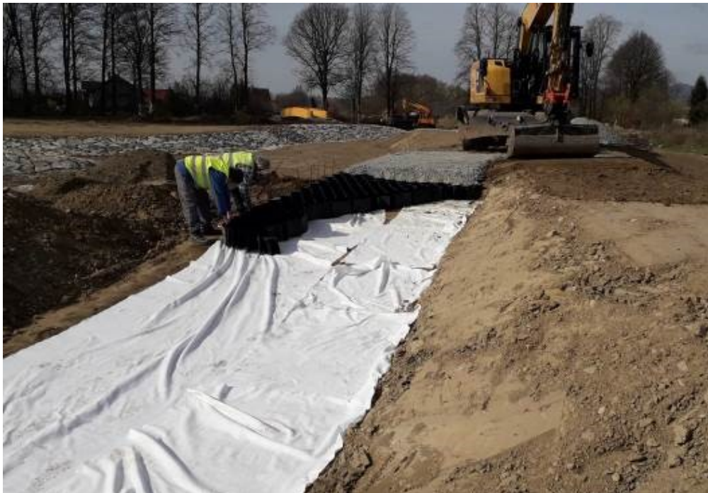
Obrázek 1: montáž geotextilie a geobuněk v povodňovém parku č. 4
