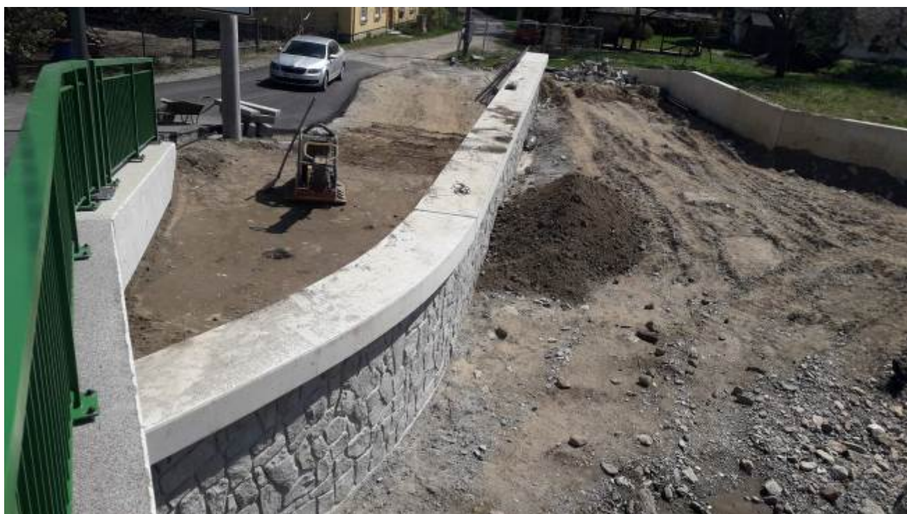
Obrázek 3: Provádění hutněných zásypů u SO11
