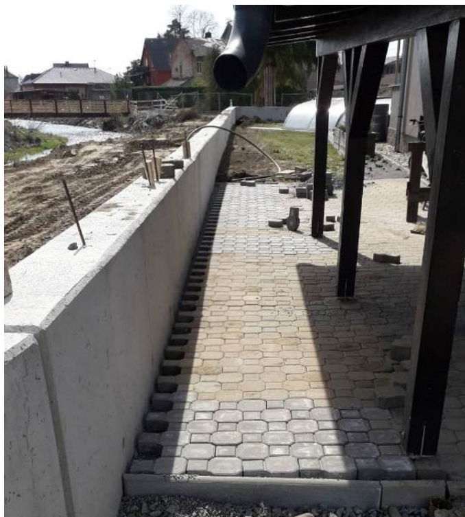
Obrázek 8: Monolitická zídka a úprava dlažby SO41.1
