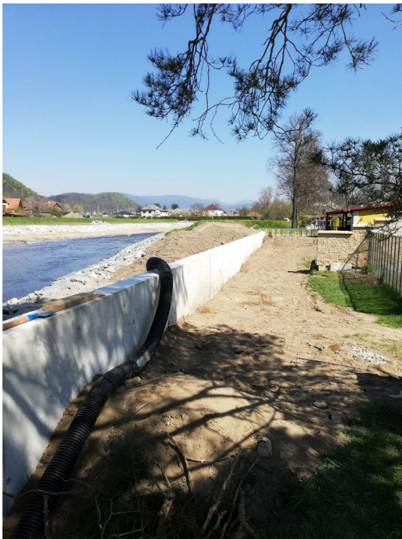
Obrázek 10: Monolitická zídka SO43 – zpětné zásypy
