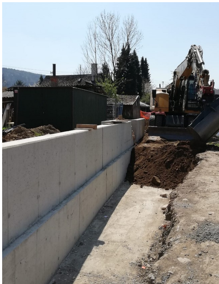
Obrázek 6: Provádění zásypů u SO38.2
