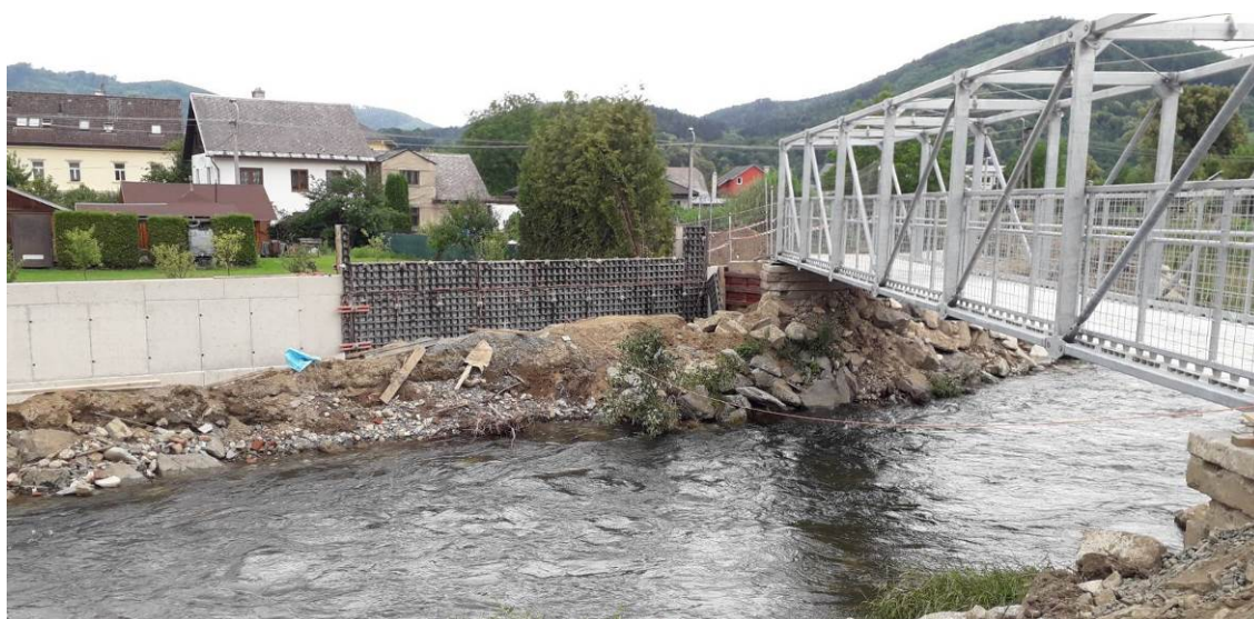
Obrázek 2: osazení nové provizorní lávky
