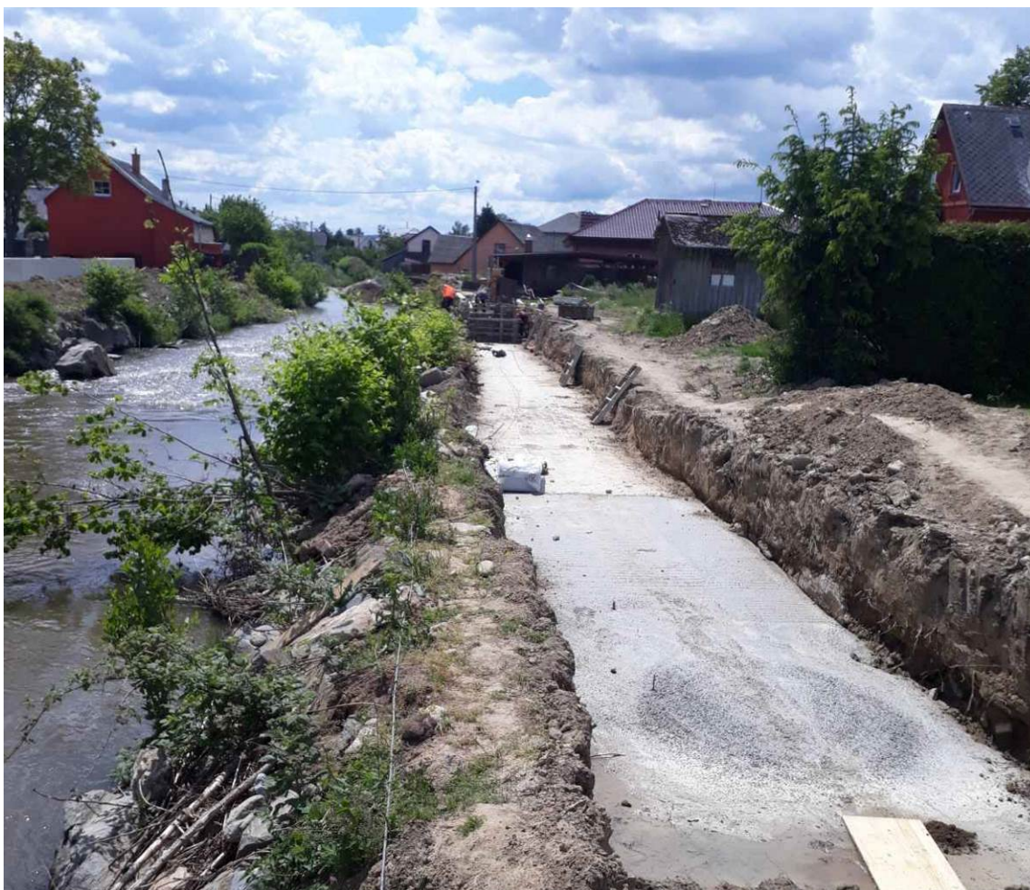
Obrázek 6: podkladní beton SO36.1
