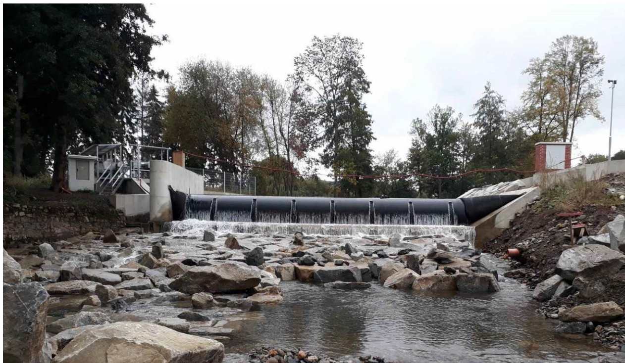
Obrázek 1: balvanitý skluz v podjezí SO01.1
