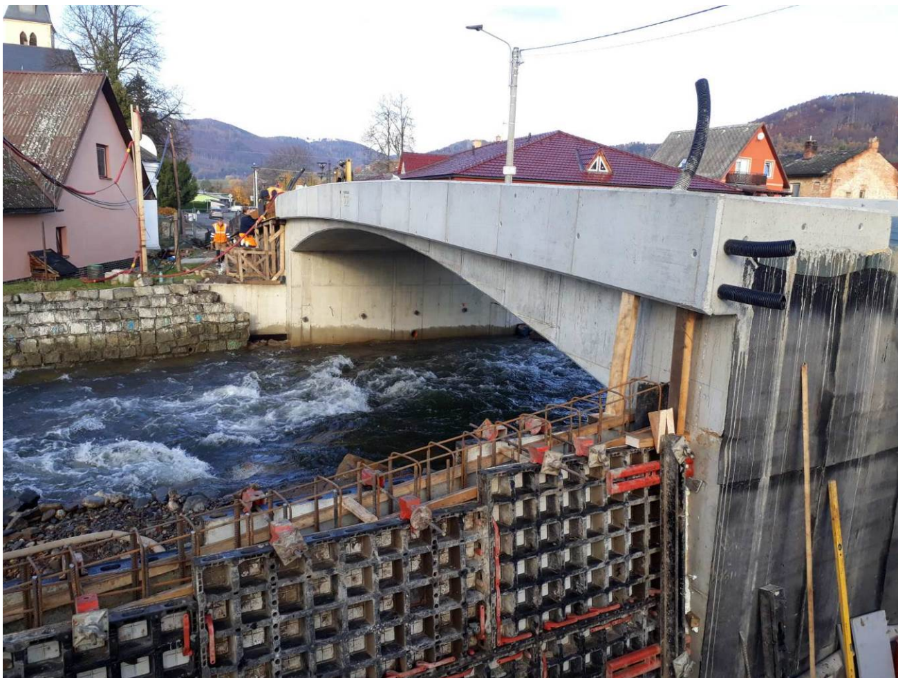
Obrázek 5: Most SO35 a bednění monolitické stěny SO3
