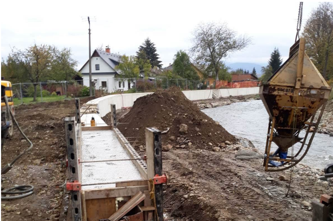
Obrázek 3: provádění monolitické zdi SO16
