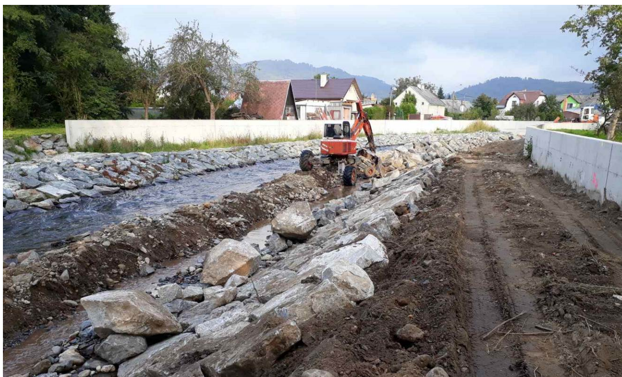
Obrázek 2: provádění kamenných záhozů na SO09
