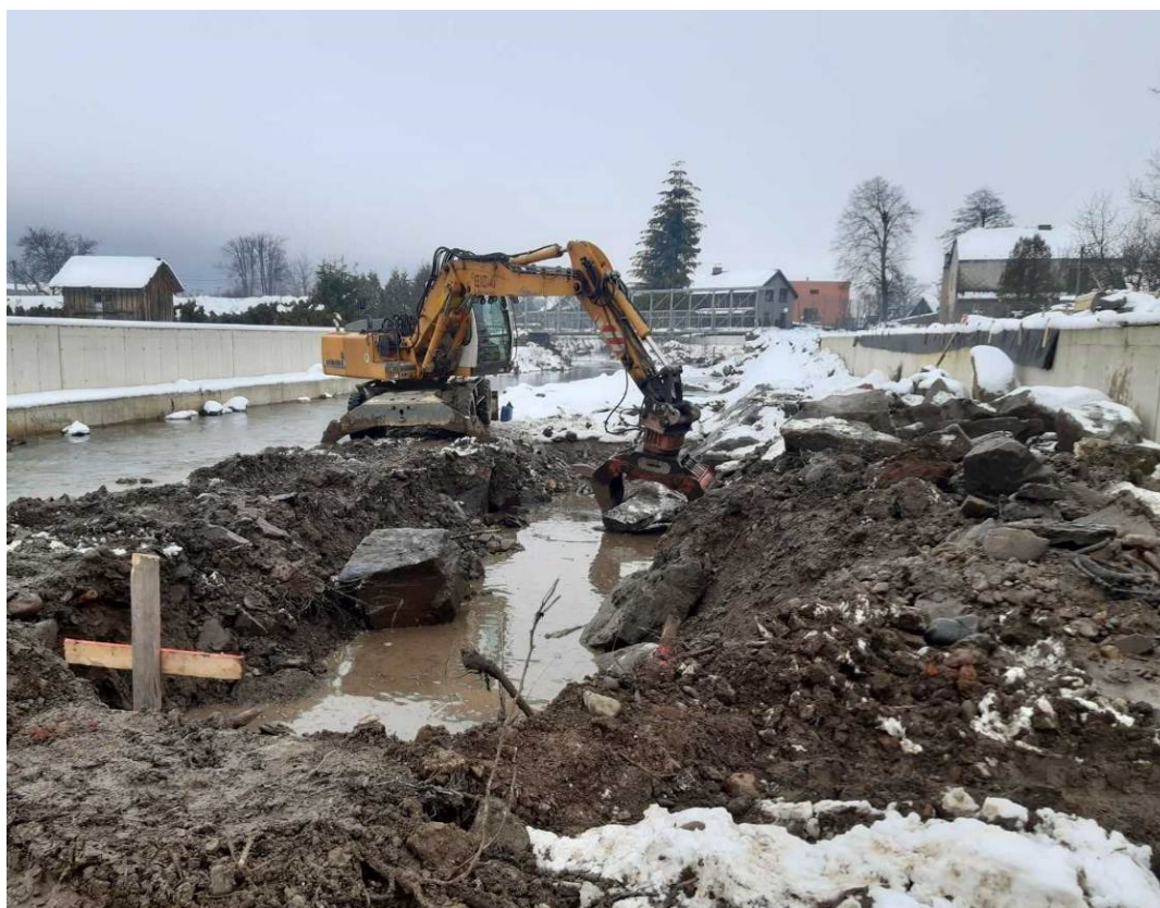
Obrázek 6: provádění kamenných záhozů na SO38.2
