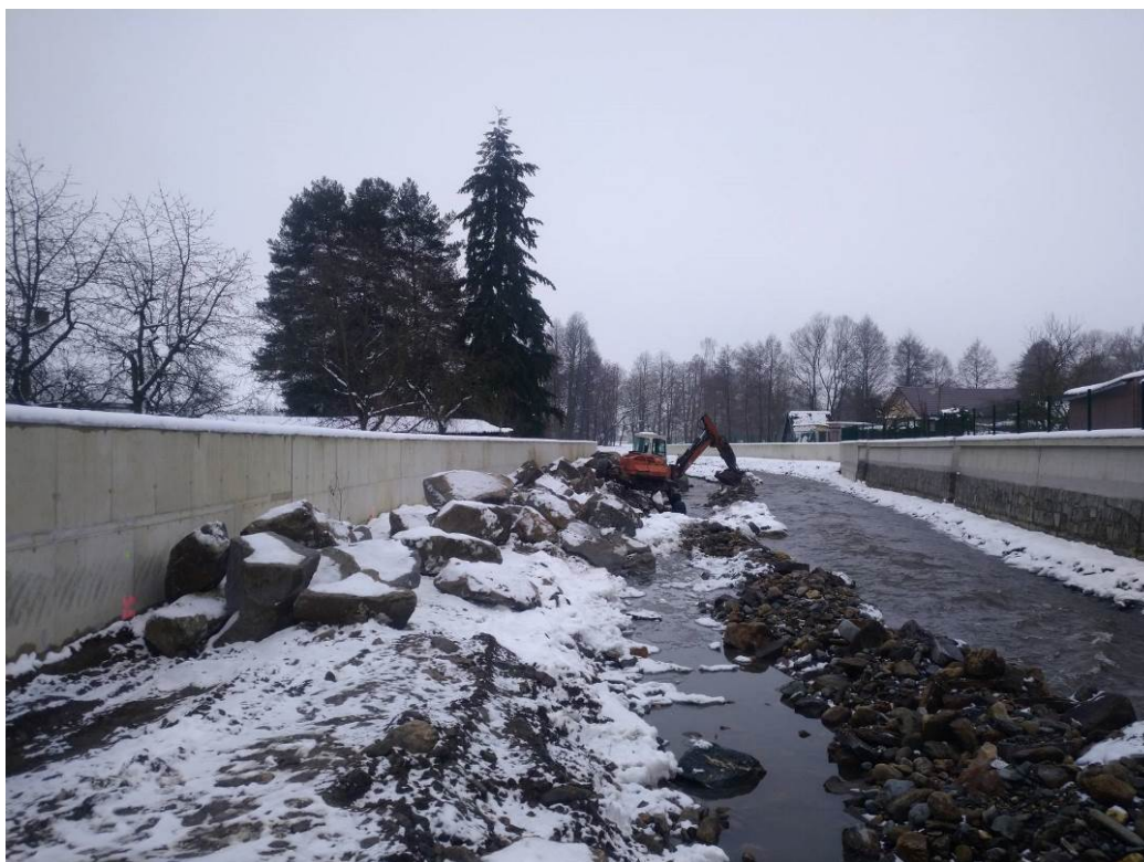
Obrázek 2: provádění kamenných záhozů na SO09
