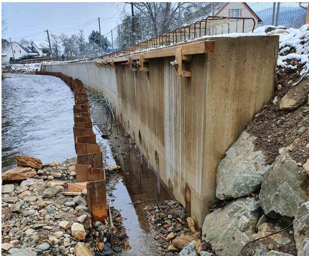
Obrázek 5: zahájení bednění římsy na SO31
