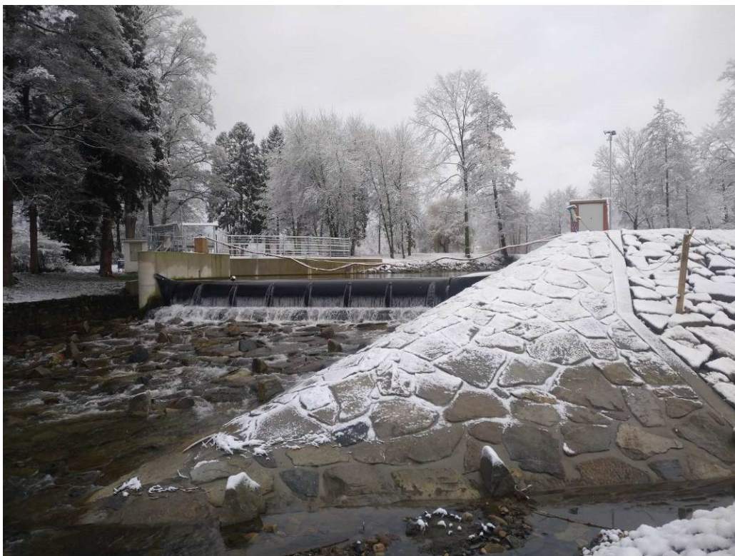
Obrázek 1: kamenné dlažby na SO01
