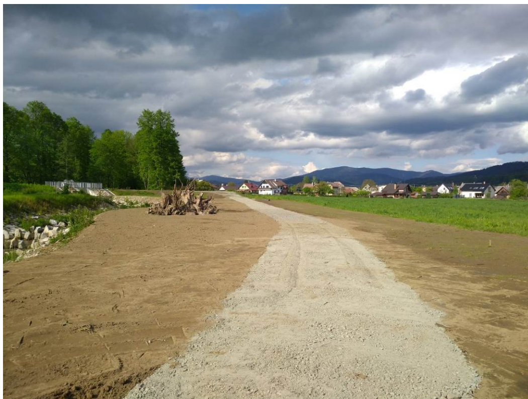
Obrázek 2: příjezdová komunikace na SO10.2
