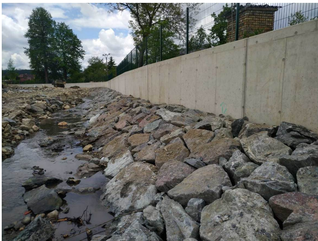
Obrázek 3: provádění záhozů na SO16
