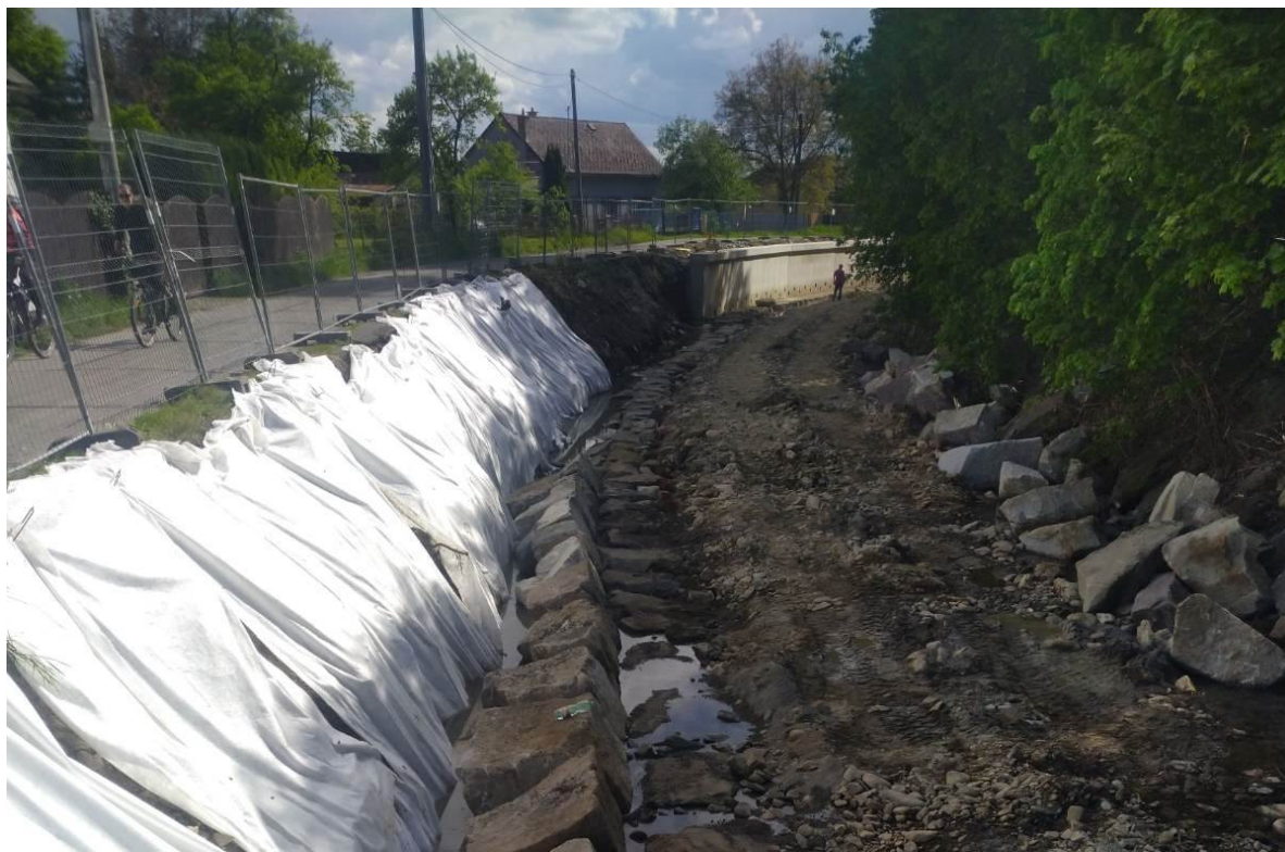
Obrázek 6: založení kamenné zdi SO31
