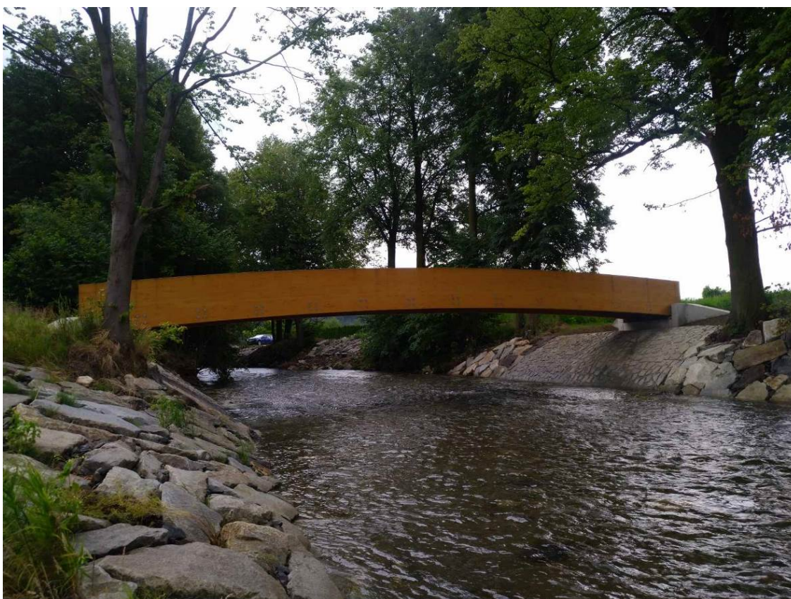
Obrázek 4: dokončení dlažeb a záhozů kolem lávky SO18.3
