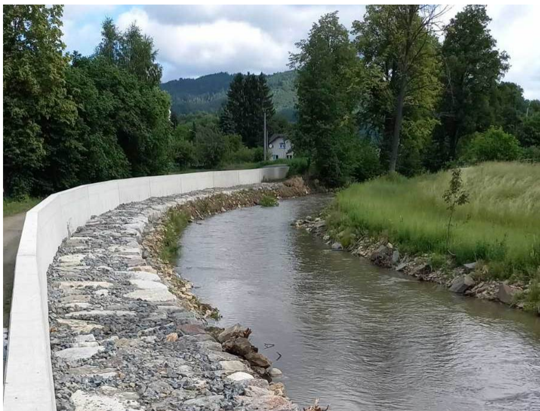
Obrázek 2: proštěrkování bermy SO13
