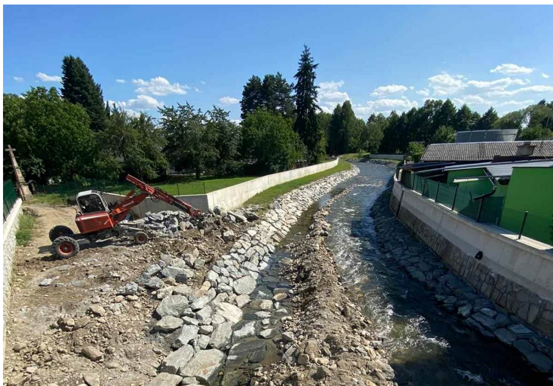
Obrázek 1: dokončování kamenných záhozů na SO09
