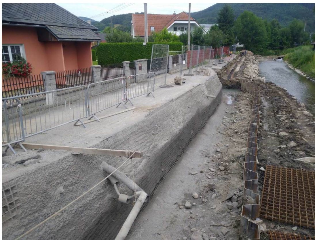
Obrázek 6: torkretová stěna na SO37.1
