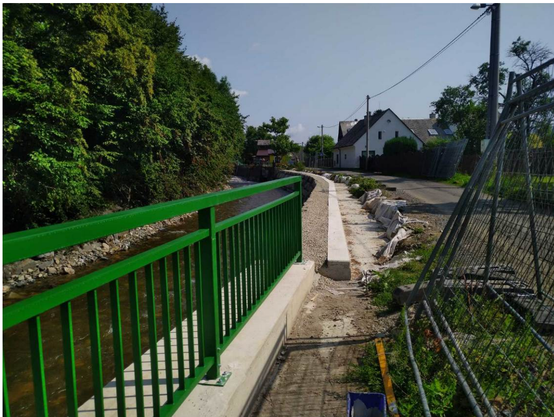
Obrázek 5: osazování zábradlí na SO31
