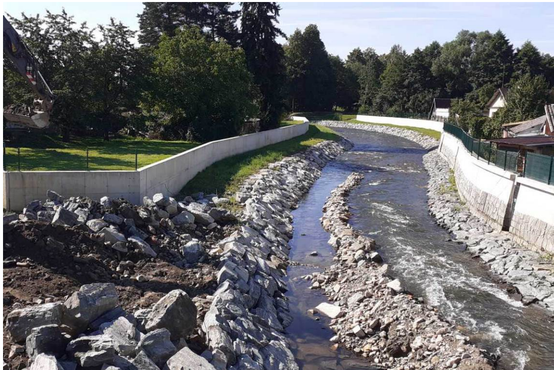
Obrázek 1: dokončování kamenných záhozů na SO09
