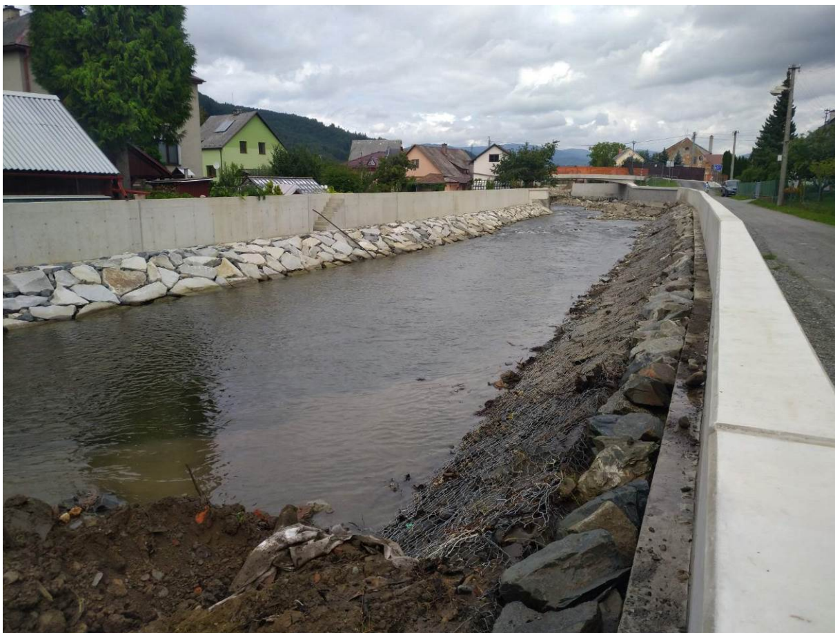
Obrázek 5: očištění gabionů na SO33.1
