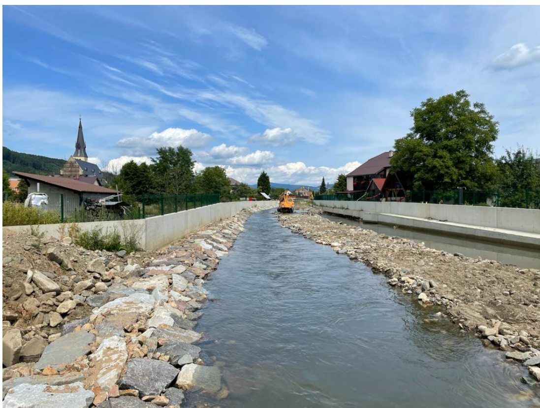
Obrázek 4: pomocná berma na SO32
