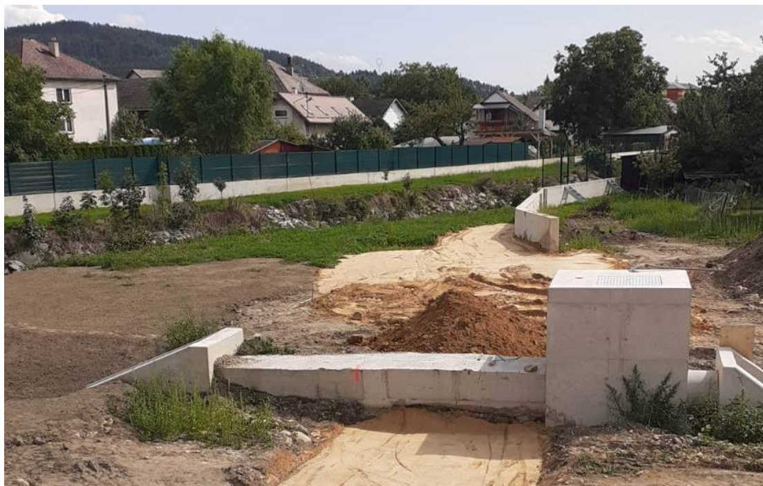
Obrázek 2: sypání hráze SO41.2
