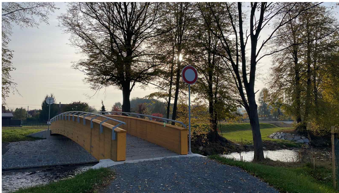
Obrázek 3: osazení dopravních značek na lávkách
