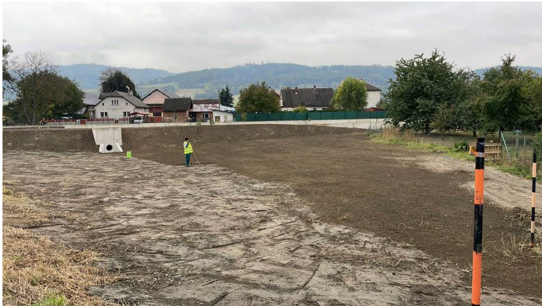
Obrázek 5: osetí na objektu SO41.2
