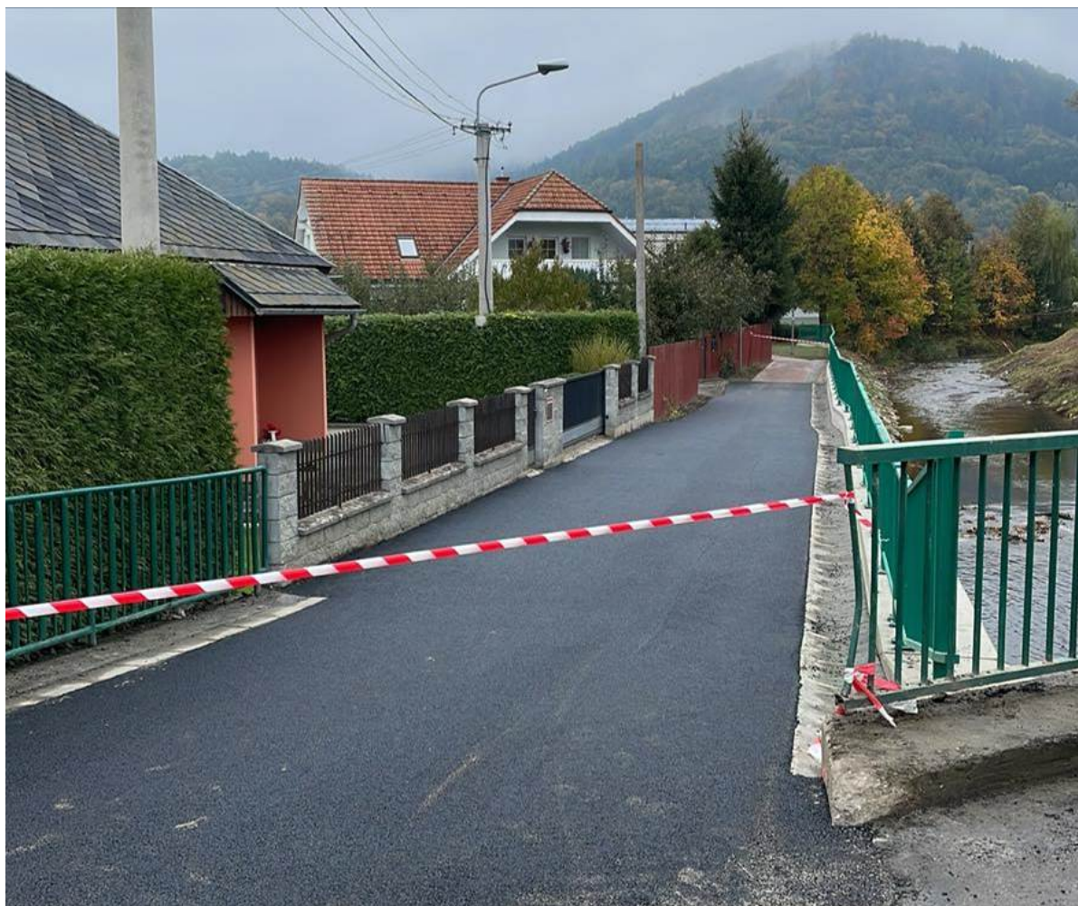
Obrázek 4: asfaltování na objektu SO37.1
